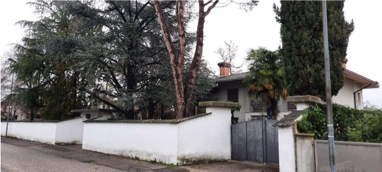
Via Italo Svevo ,40 Portogruaro (VE) – ingresso pedonale e carraio
