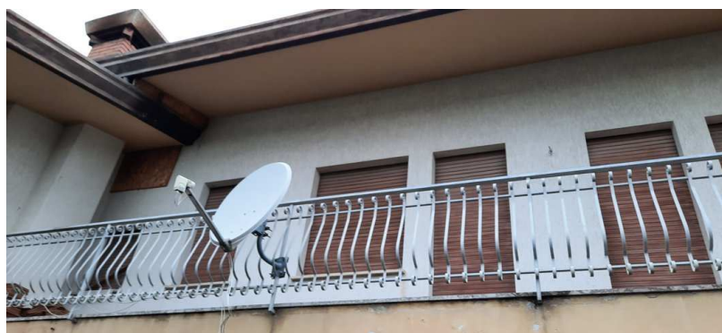
Balcone delle camera 1 e camera 2
