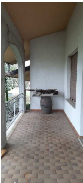
Terrazzo coperto Piano Primo a servizio del soggiorno
