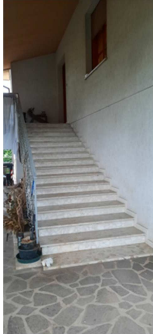
accesso piano terra e piano primo
