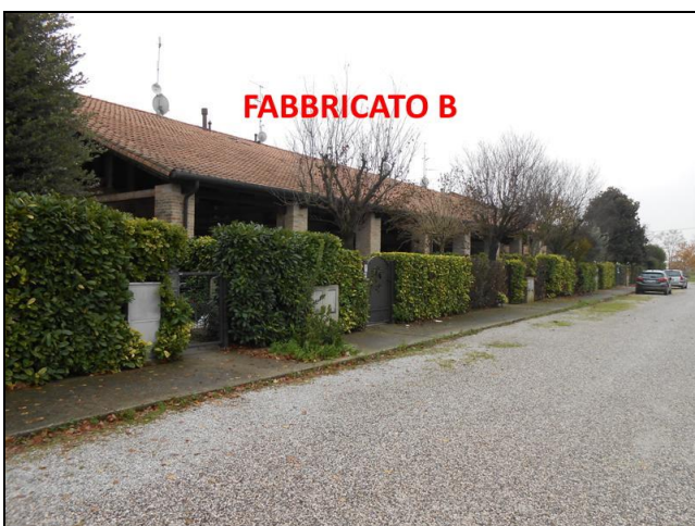
Fabbricato B di cui fa parte l'abitazione pignorata
