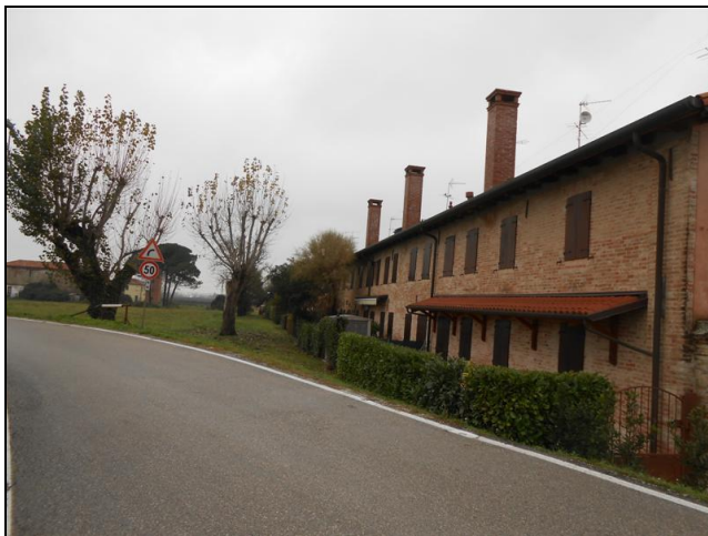
Fabbricato B – veduta dallo Stradone R. Franchetti
