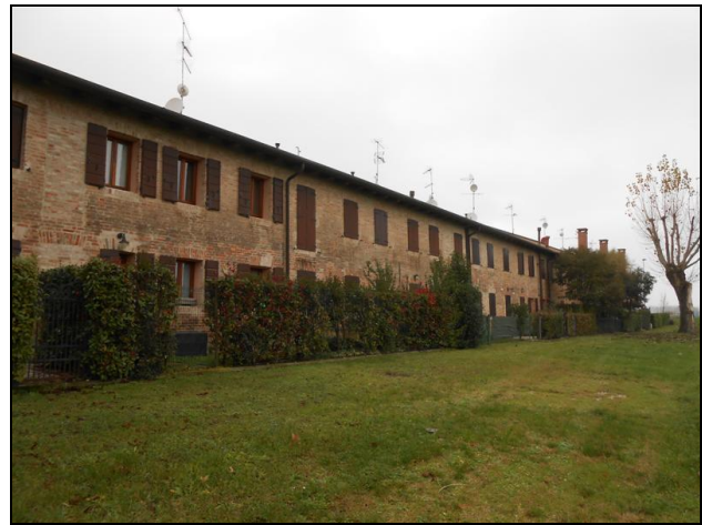
Fabbricato B – fronte est
