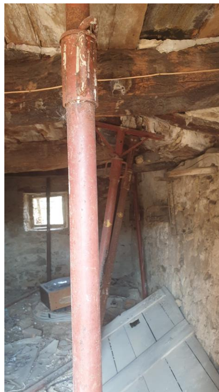
Interno locali piano terra
