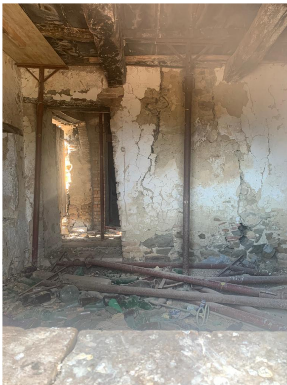
Interno locali piano terra
