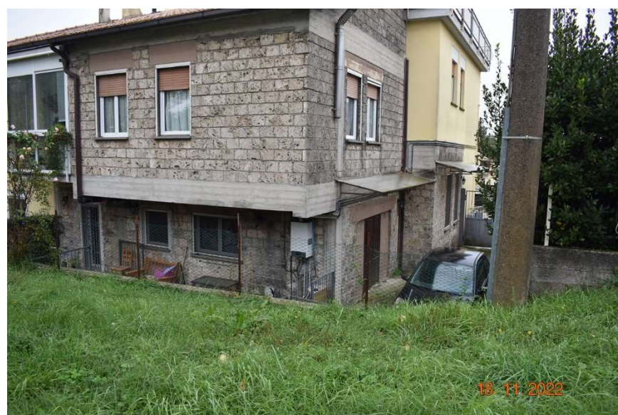
Foto 03 Vista dell'immobile fronte Nord-Est
