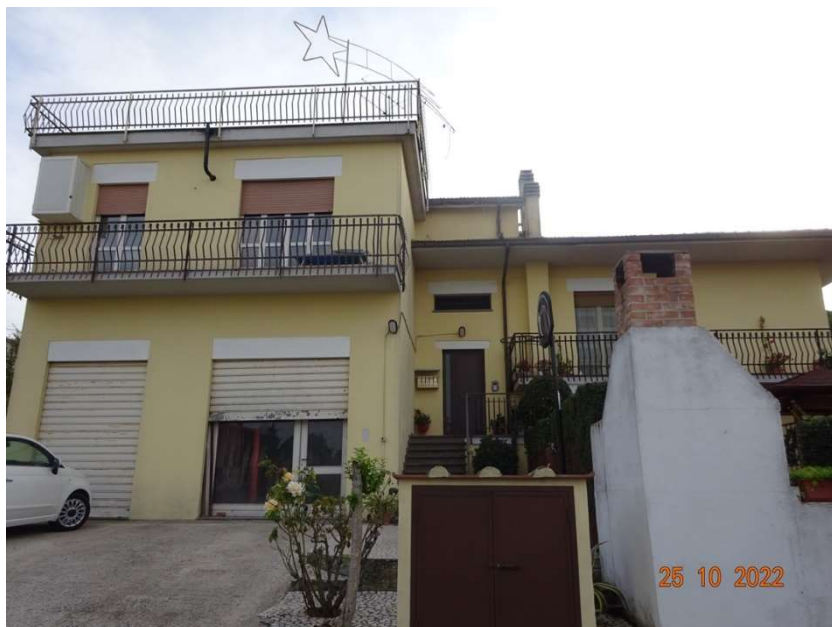
Foto 01 Vista dell'accesso all'edificio condominiale prospetto Ovest
