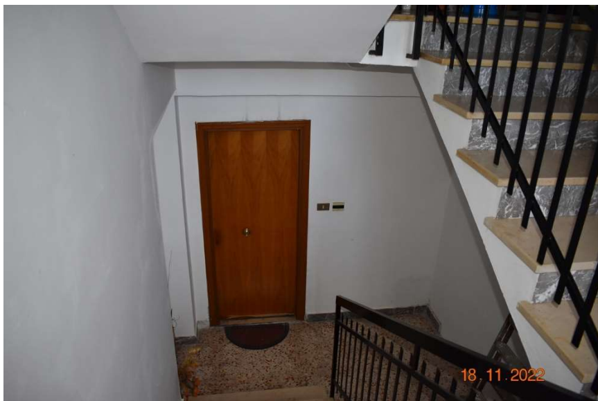
Foto 07 Portoncino di accesso dalla scala condominiale
