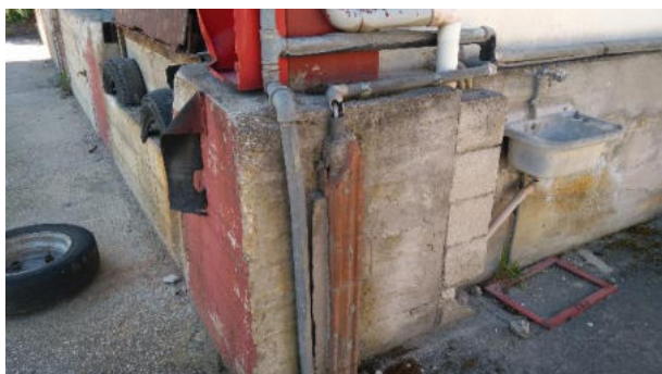
Impianti (esterno Fabbricato)_01
