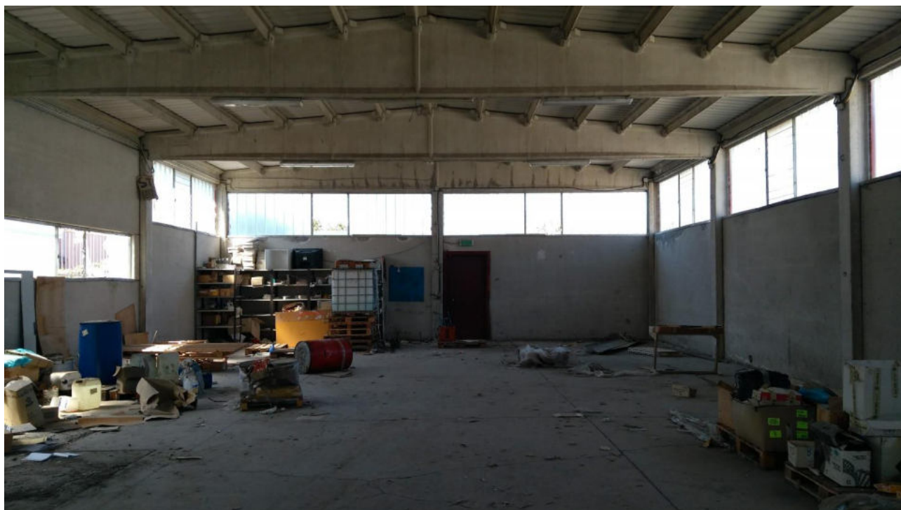
Interno fabbricato – fronte posteriore (movimentazione merci)
