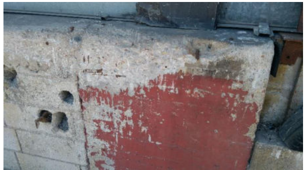
Cemento (esterno Fabbricato)_04
