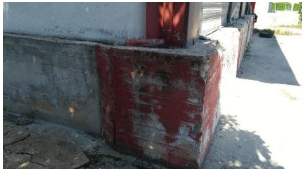
Cemento (esterno Fabbricato)_06
