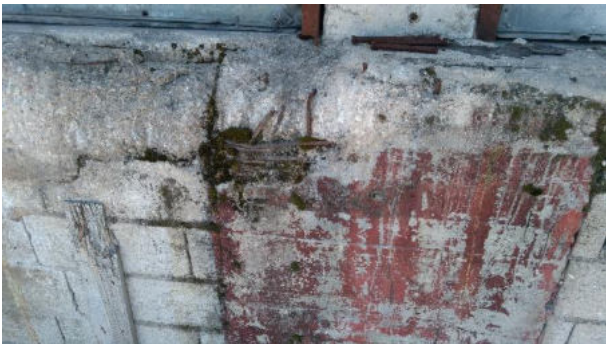
Cemento (esterno Fabbricato)_05
