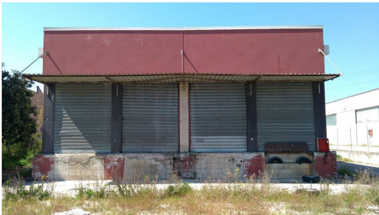
Fronte principale (movimentazione merci)
