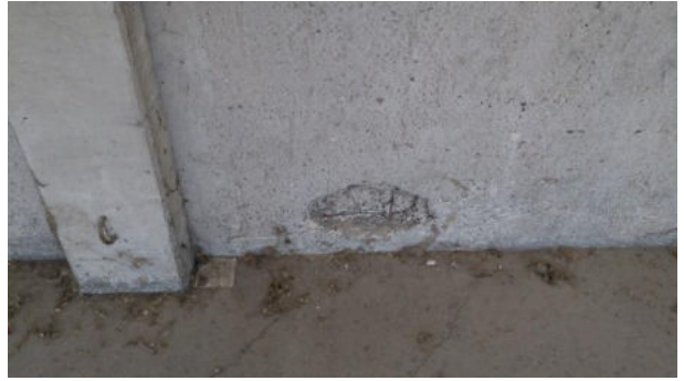
Cemento (interno Fabbricato)_02
