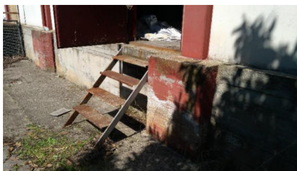
Particolare ingresso laterale_02
