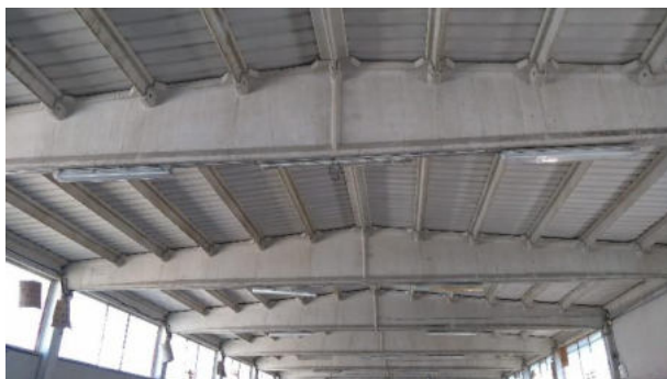
Particolare capriata - copertura_01
