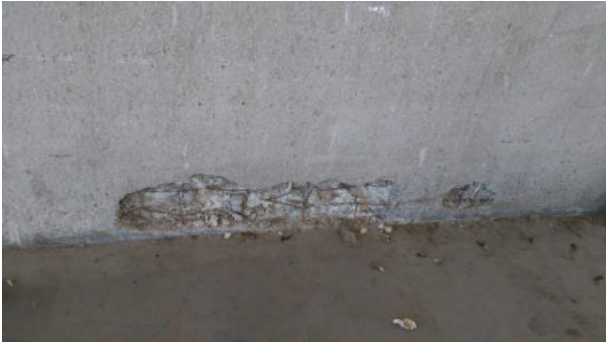
Cemento (interno Fabbricato)_01
