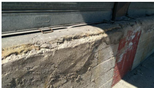
Cemento (esterno Fabbricato)_07
