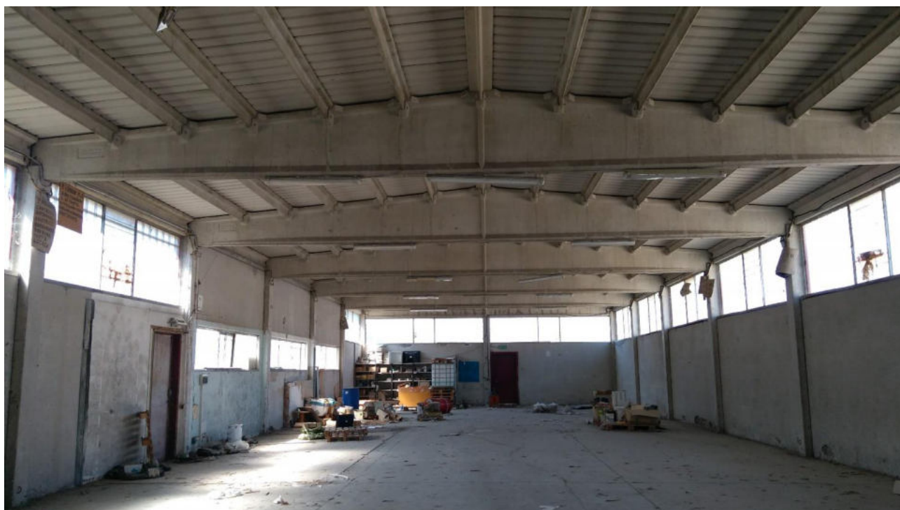
Interno fabbricato - fronte posteriore
