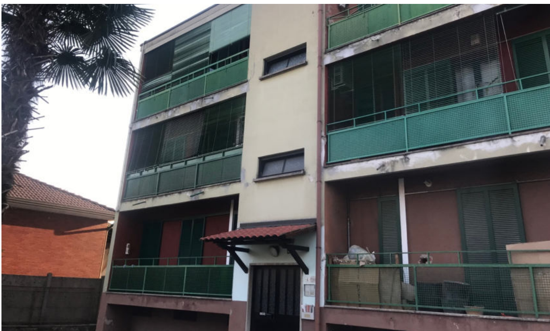
Foto n. 2: Vista esterna balcone appartamento da ingresso condominiale
