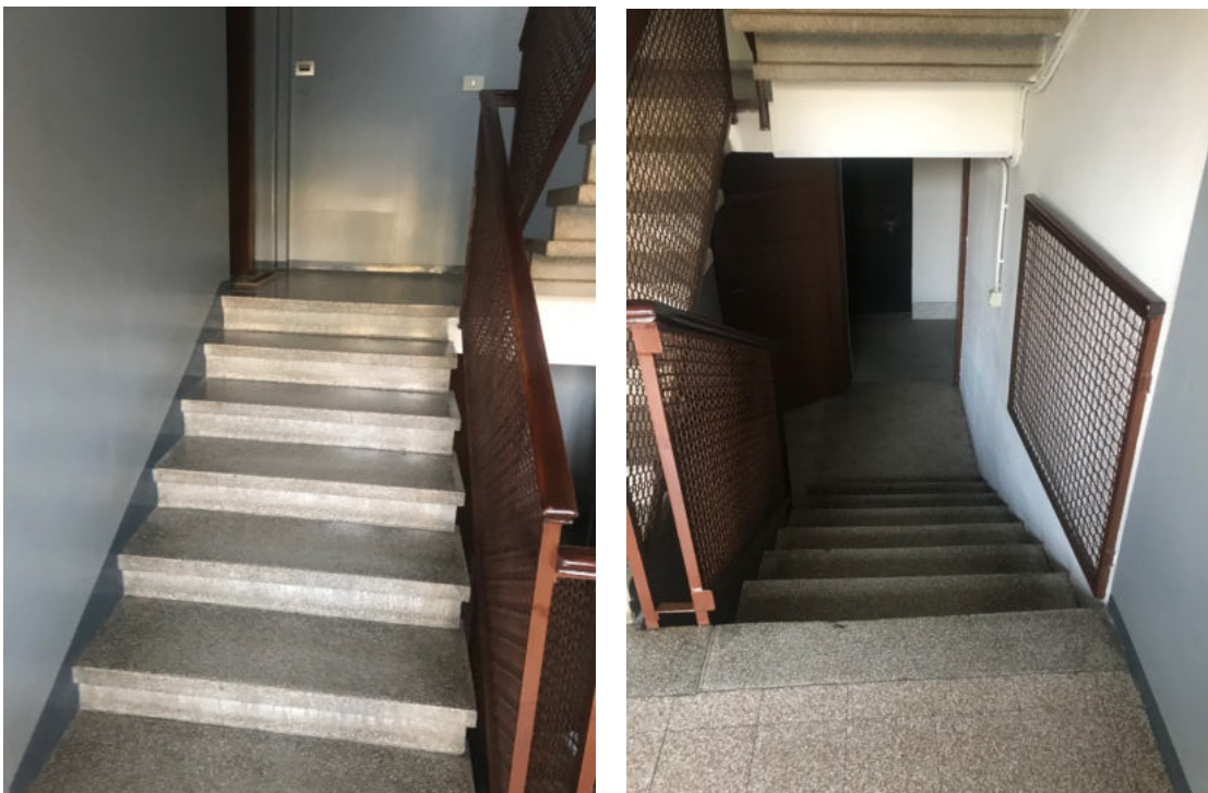
Foto n. 5 e n.6: Scale condominiali fabbricato residenziale
