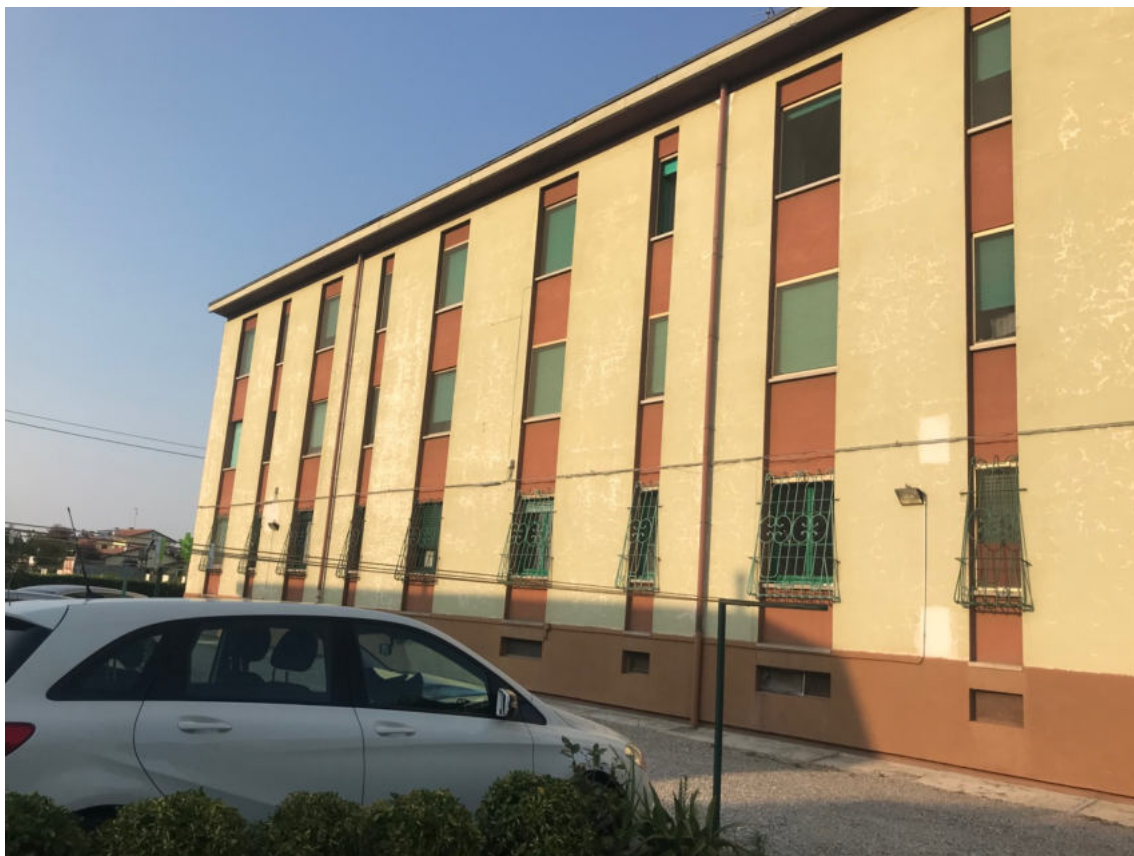
Foto n. 3: Vista facciata fronte cortile retrostante edificio residenziale
