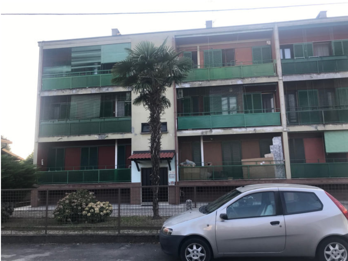
Foto n. 1: Vista ingresso da civico 4 via A.Volta
