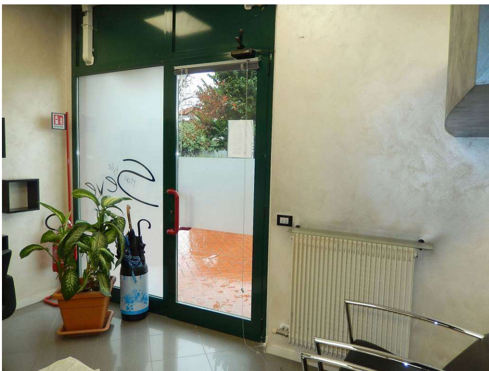
Foto 6 – L'ingresso del negozio sul lato strada.
