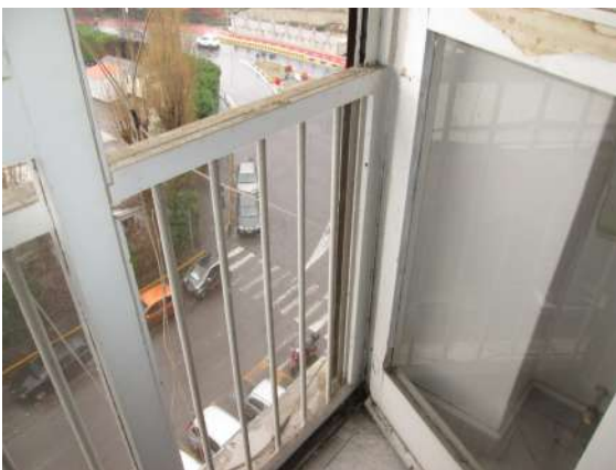
7) Finiture serramenti esterni
