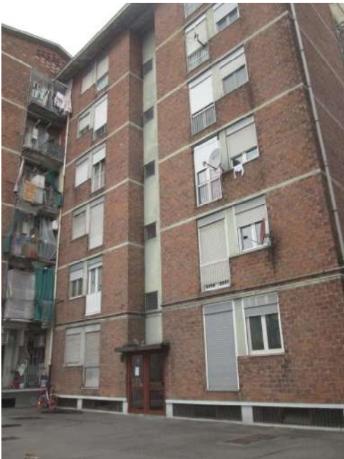
2) L'ingresso alla scala C
