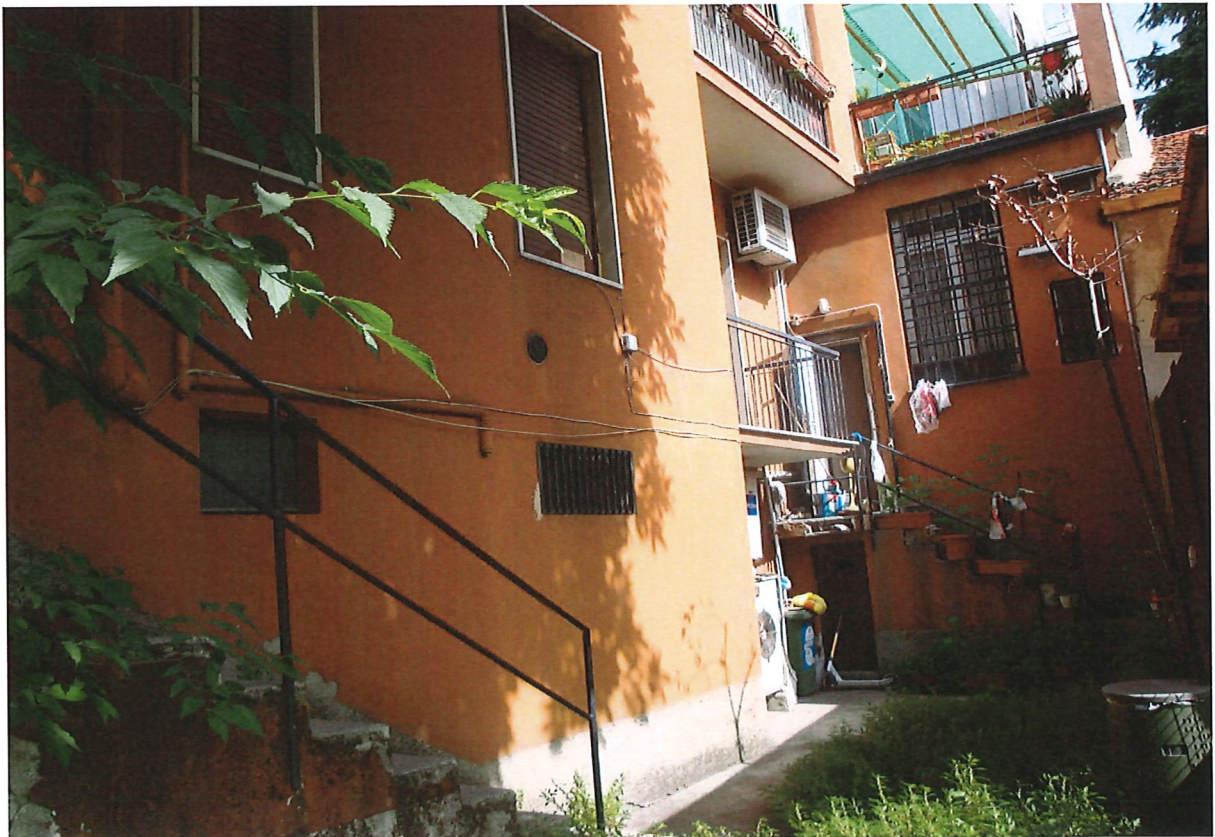
R.G.E. 1713/2019 G. E. Dott.ssa M. Galioto Milano, Via Luigi Ornato n.° 56, piano 6°-S1, Foglio 46, mapp. 51, sub. 28 Prospetti esterni: la facciata est con affaccio sul cortile interno, l'ingresso alle cantine
