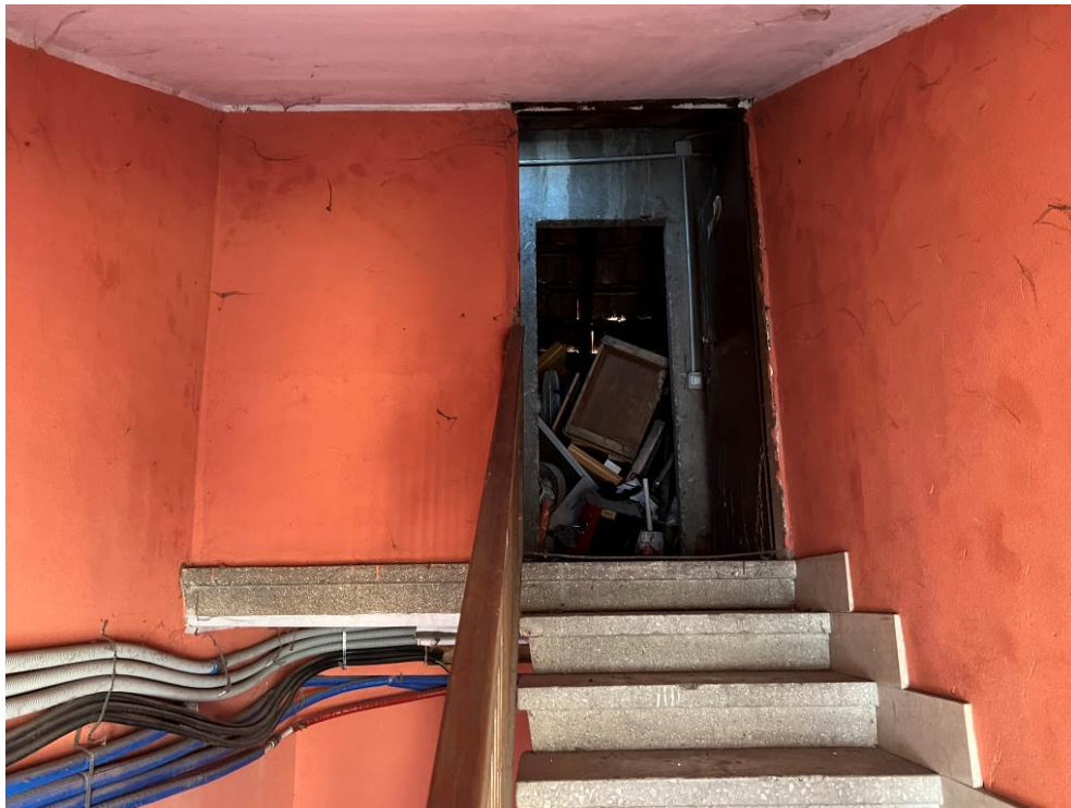
Fotografia n. 21 – Vista della scala che conduce al piano sesto sottotetto
