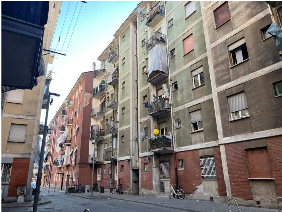
Fotografia n. 1 – Facciata principale del "Condominio Tuberose" al civico n. 17 di Piazza Giuseppe Garibaldi a Pioltello (Mi),
