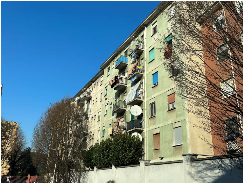
Fotografia n. 2 – Facciata secondaria del “Condominio Tuberose” al civico n. 17 di Piazza Giuseppe Garibaldi a Pioltello (Mi), su cui affaccia l'appartamento oggetto della procedura al piano quarto
