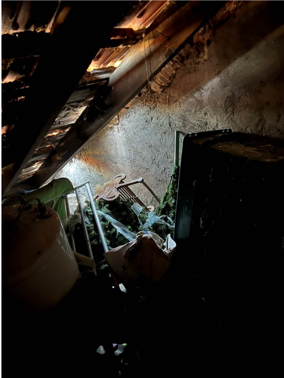
Fotografia n. 22 – Vista del vano di solaio oggetto della procedura al piano sesto sottotetto
