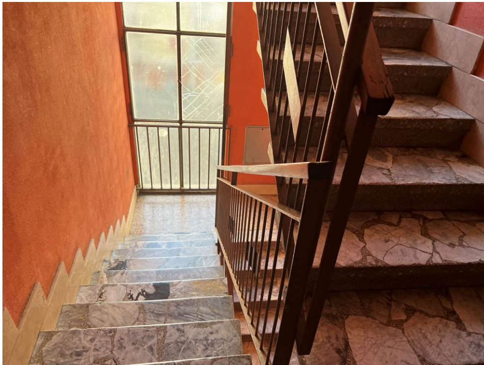
Fotografia n. 7 – Vista del corpo scale, privo di ascensore
