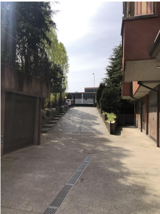
Vista rampa e corsello boxes
