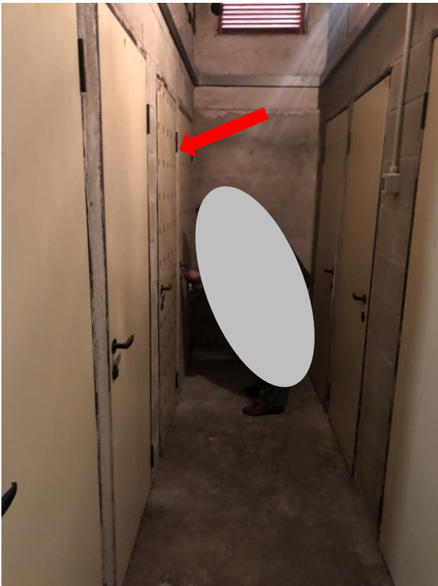
Vista locali cantine
