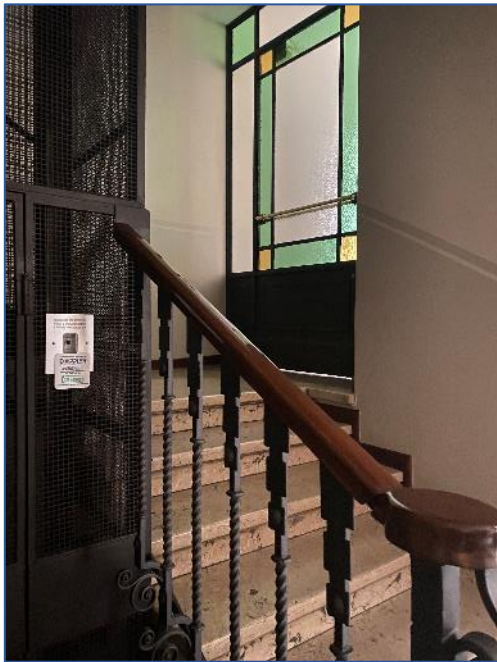
Foto 5 - vano scala comune
