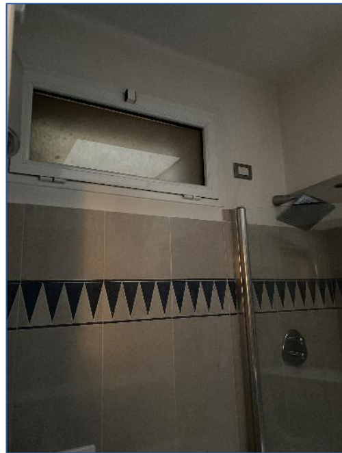
Foto 24 – dettaglio serramento bagno su spazi comuni
