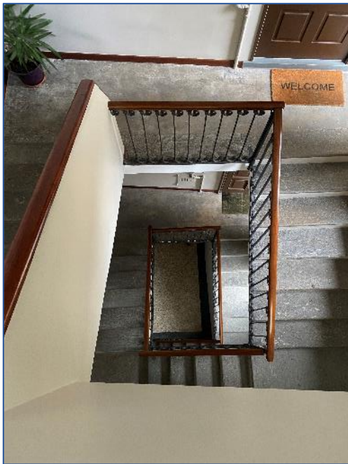
Foto 7 - vano scala comune
