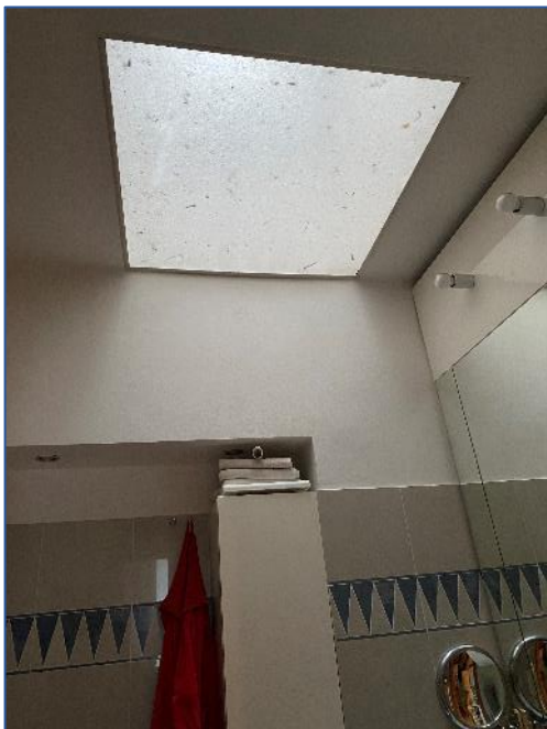
Foto 25 – dettaglio lucernario bagno
