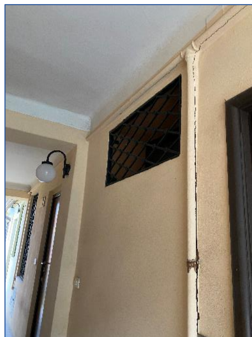
Foto 16 - dettaglio serramento bagno su spazi comuni
