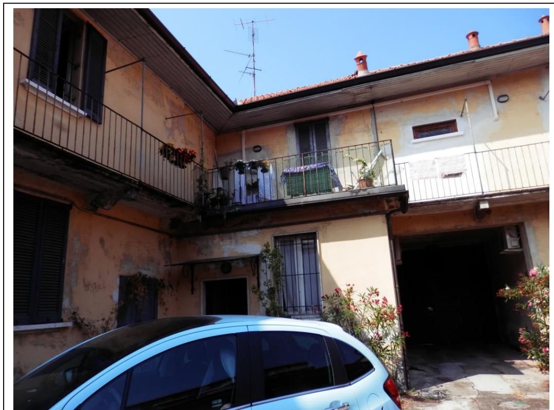
Fotografia n°2 – Vista del fronte interno del fabbricato rivolto sul cortile interno.
