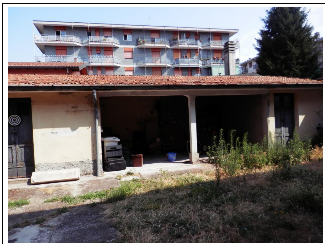
Fotografia n°14 – Vista della porzione coperta destinata a lavanderia.
