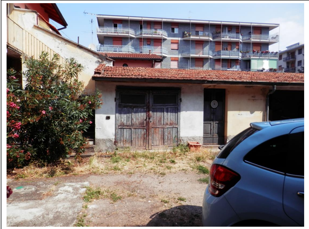
Fotografia n°11 – Vista delle porte d'accesso al box auto e al ripostiglio.
