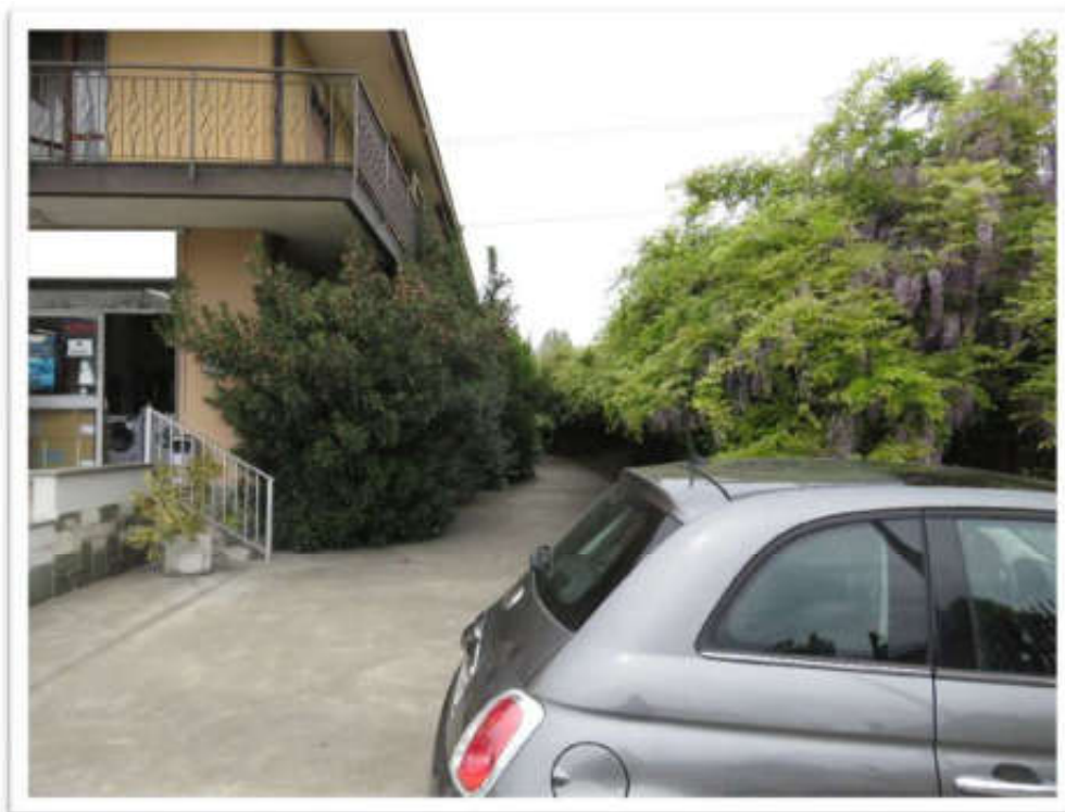
Viste laterali della palazzina in cui è ubicato il magazzino.
