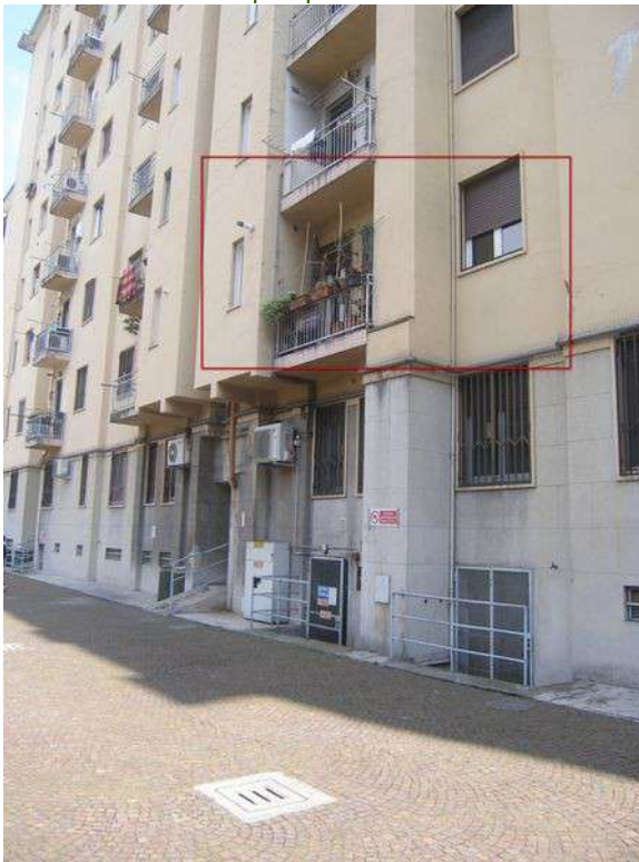
Vista dettaglio prospetto interno
