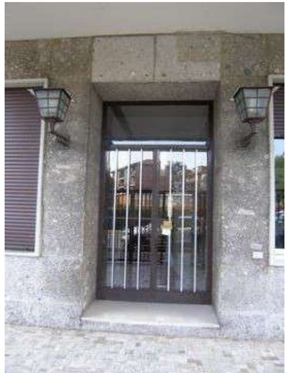
Vista ingresso scala B
