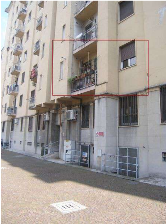
Vista dettaglio prospetto interno
