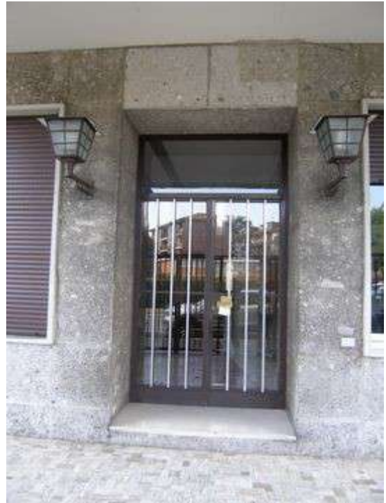
Vista ingresso scala B
