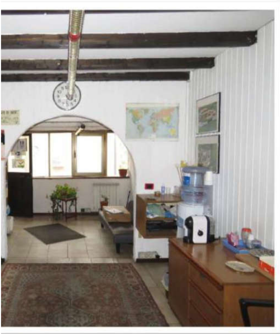
Ripostigli impropriamente utilizzati ad uffici al piano ammezzato.
