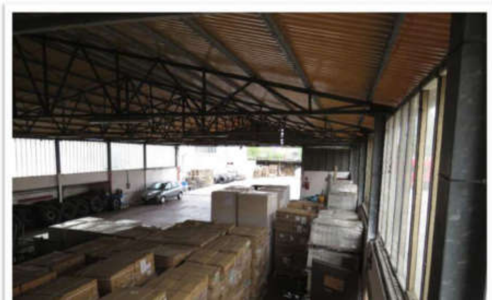
Viste interne del capannone.
