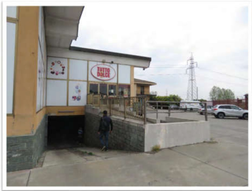
Vista dell'ingresso al capannone.
