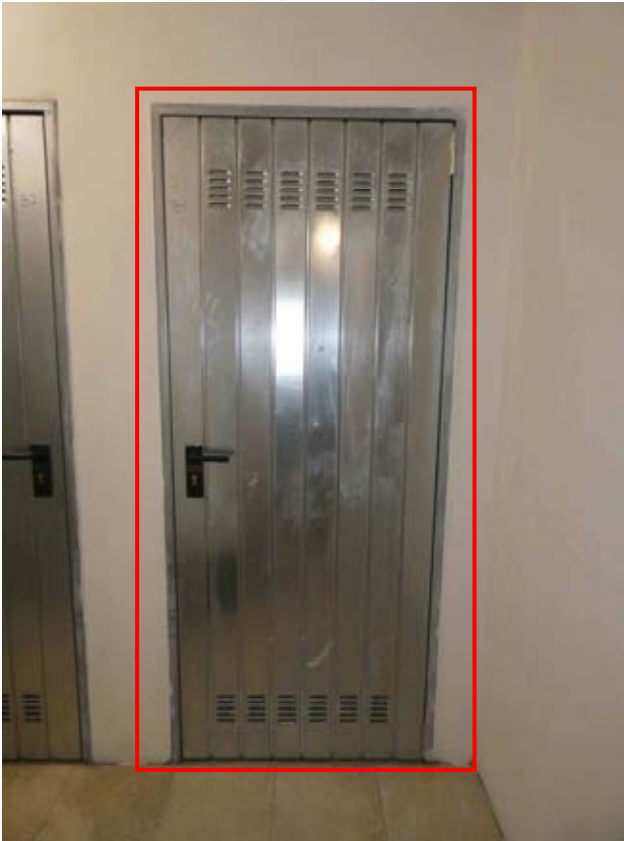
Foto 12. Porta d'accesso alla cantina
