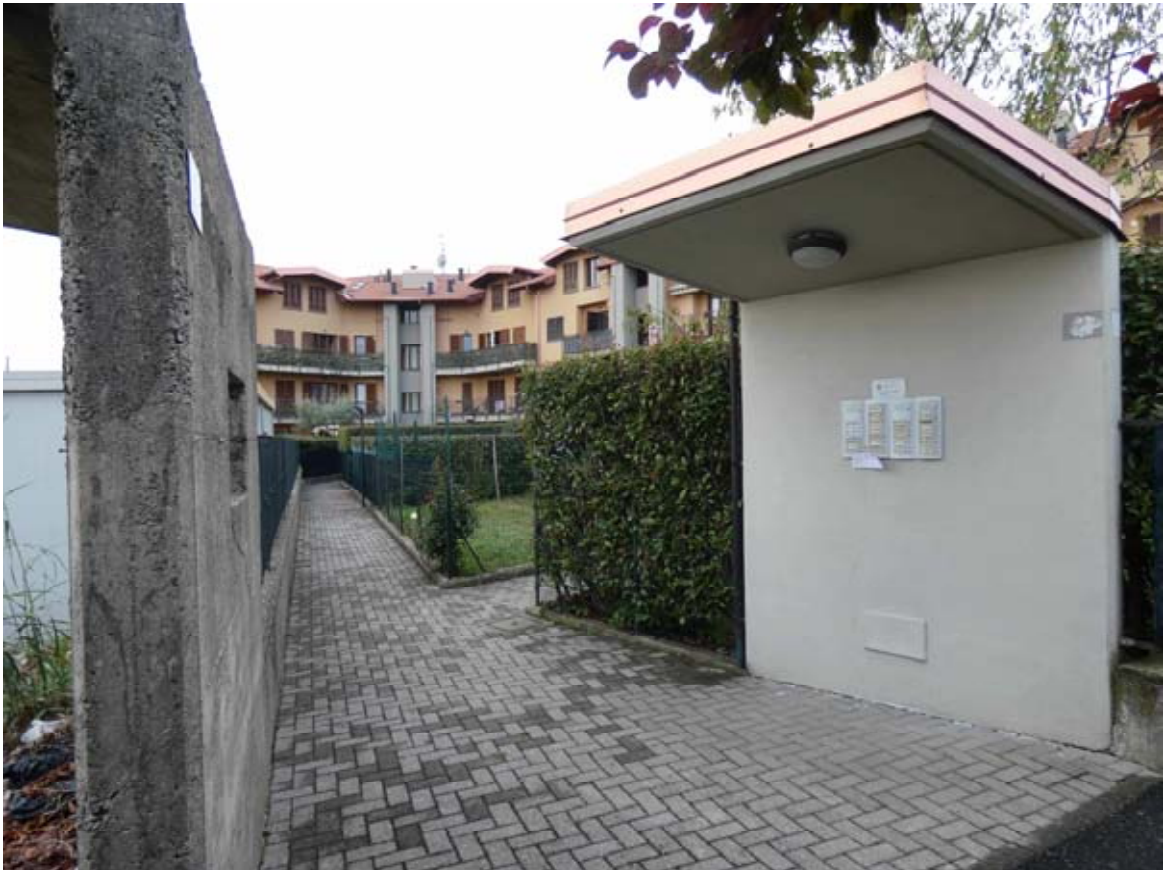
Foto 2. Ingresso pedonale complesso condominiale
