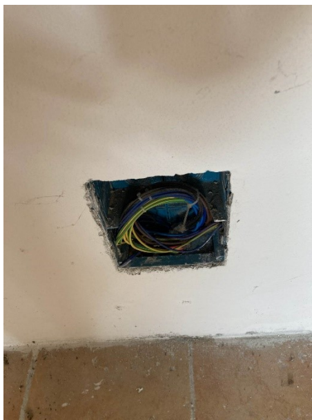
particolare impianto elettrico in fase di rifacimento al piano terra
