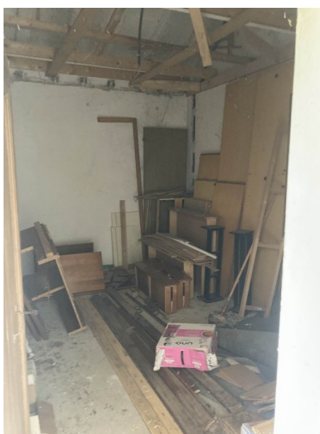
particolare ulteriore camera in corso di ristrutturazione
