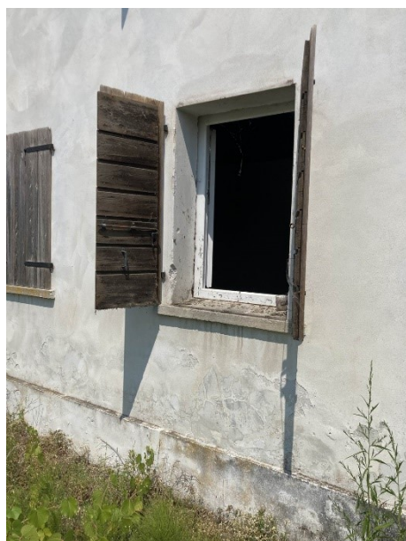
particolari umidità di risalita nelle murature
