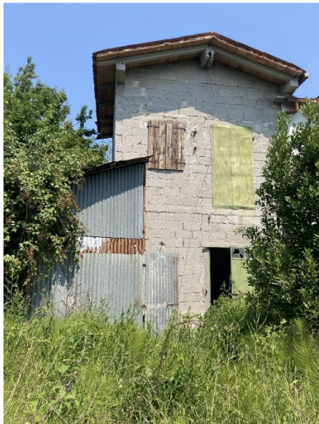
Prospetto lato Sud
