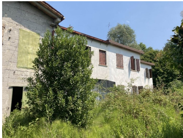
Ulteriore prospetto lato Sud
