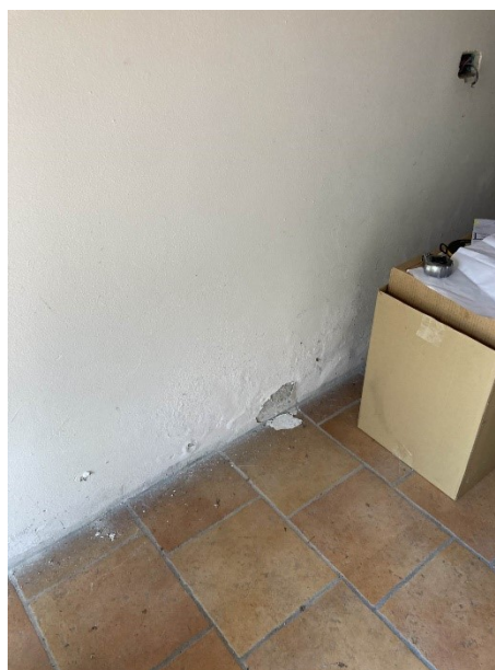
particolari umidità di risalita nelle murature
