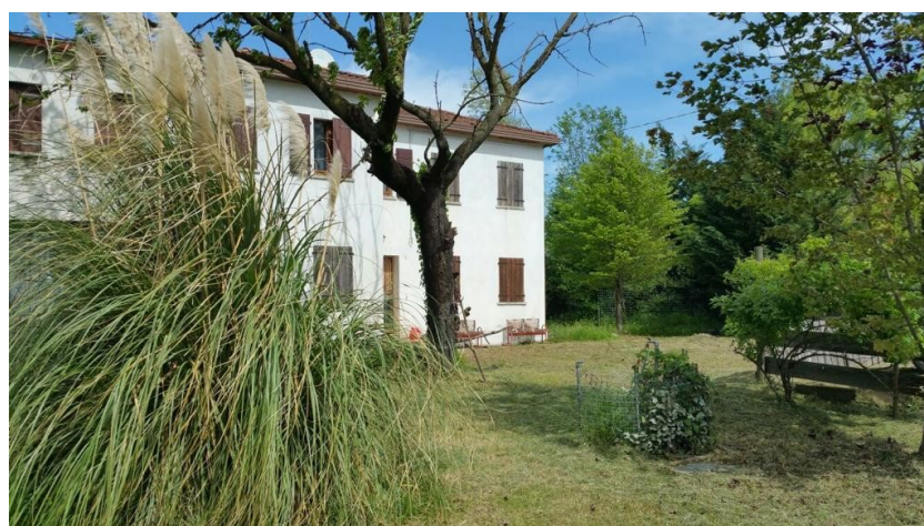
Ulteriore prospetto lato Sud
