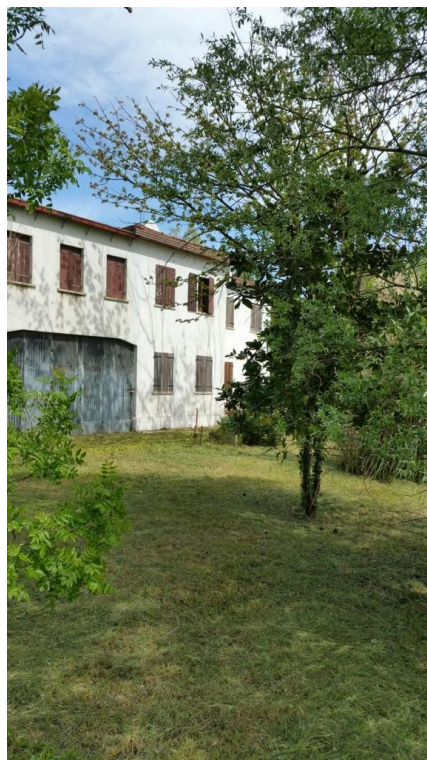
Prospetto lato Sud
