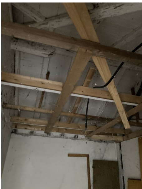
Particolare della copertura della camera in corso di ristrutturazione
