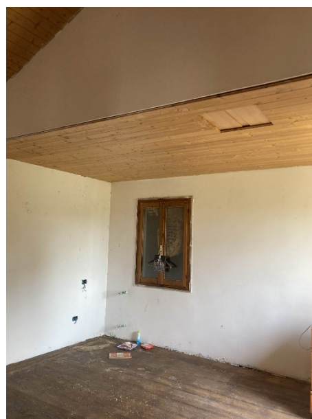
Particolare camera con controsoffitti da sistemare per garantire le altezze interne
