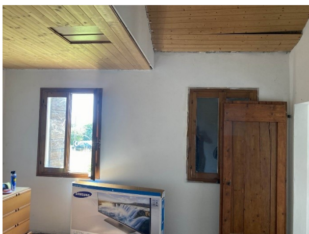
Particolare camera con controsoffitti da sistemare per garantire le altezze interne
