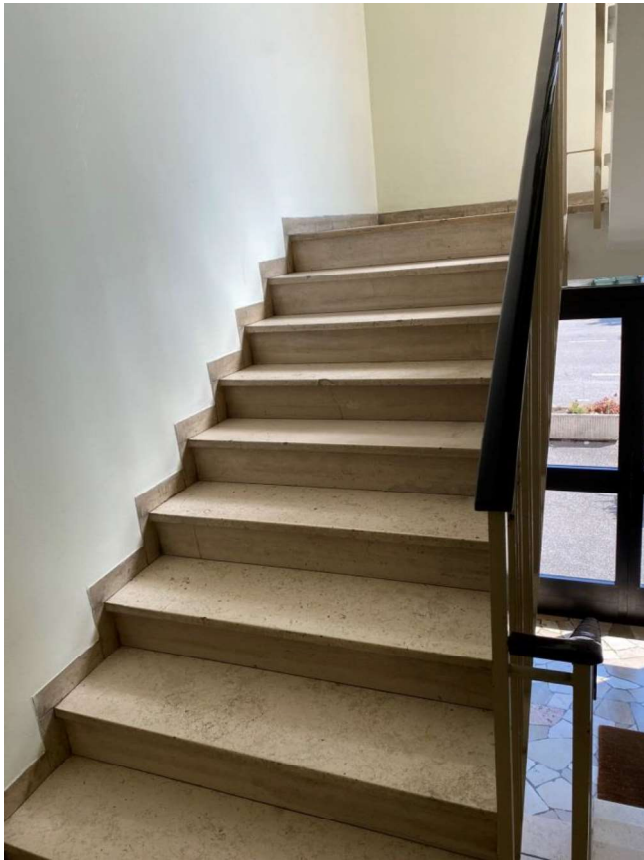
Scala condominiale ai piani fuori terra
