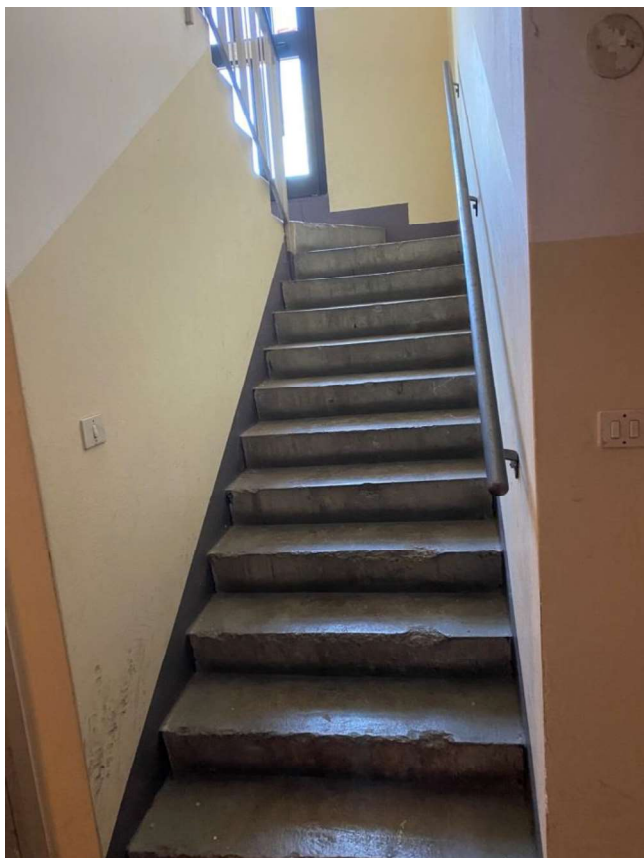
Scala condominiale al piano seminterrato
