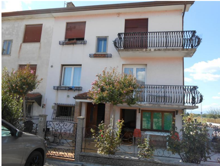
4) ingresso al civico n. 7
