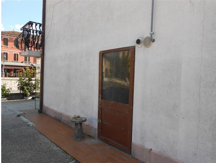
29) ingresso alla centrale termica
