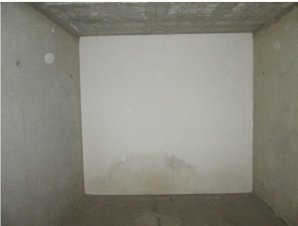
Presenza di umidità ed infiltrazioni
