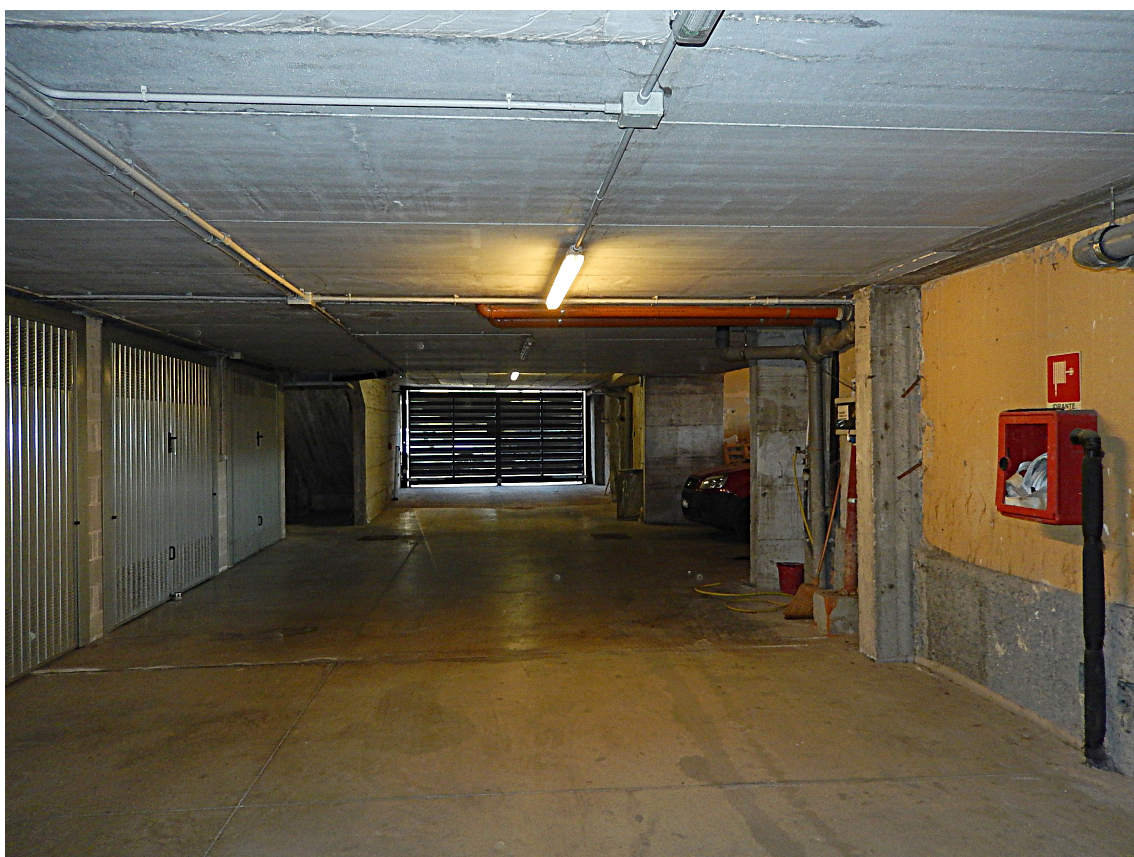
Foto 3 – Vista del corsello di manovra verso l'uscita.
