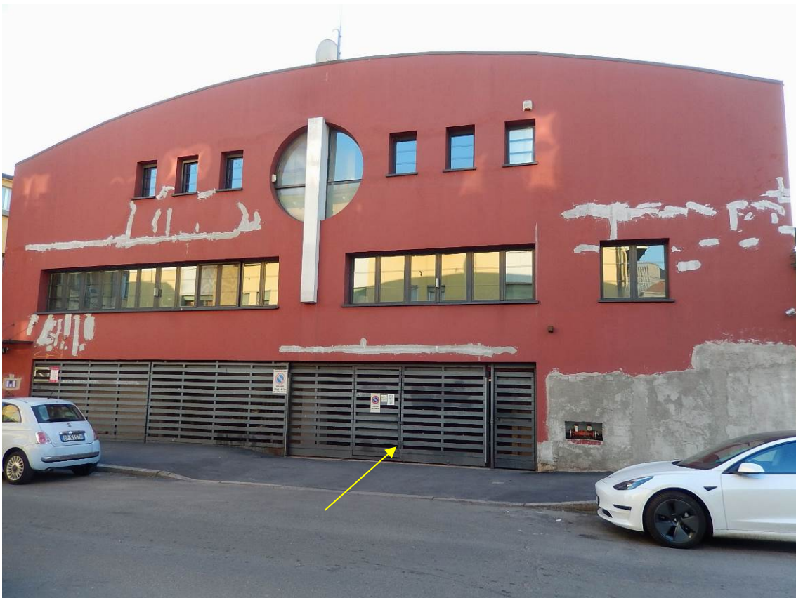
Foto 2 - Indicato dalla freccia il portone di accesso alle autorimesse.
