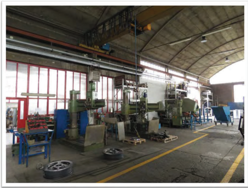
Interni del capannone.
