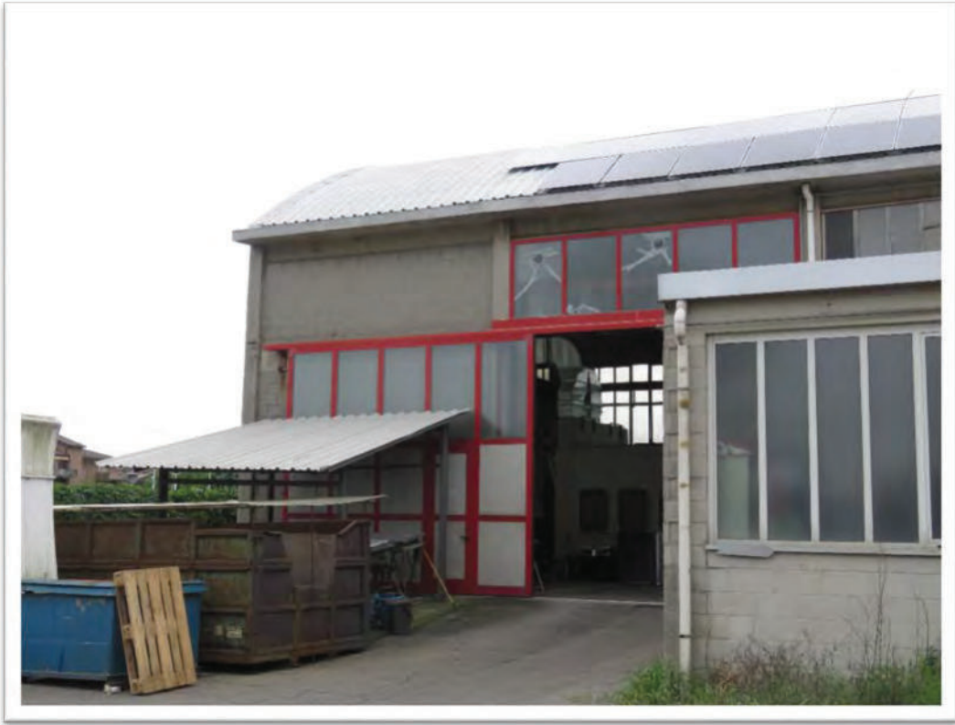
Estremità Sud del capannone ed annessi. Da notare i pannelli solari posti sulla copertura.
