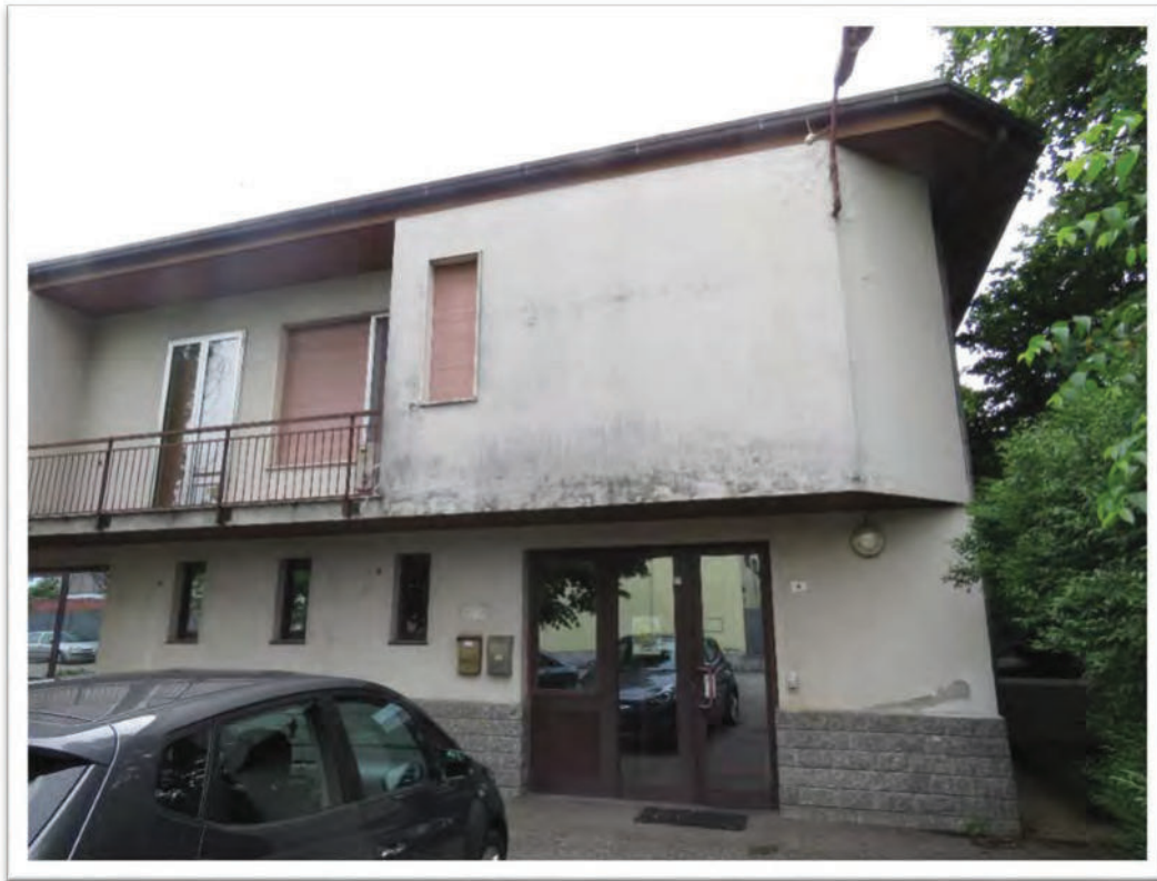
Particolare del fabbricato uffici/abitazione custode/cantina e vista del capannone da via Bologna. Da notare i pannelli solari posti sulla copertura .
