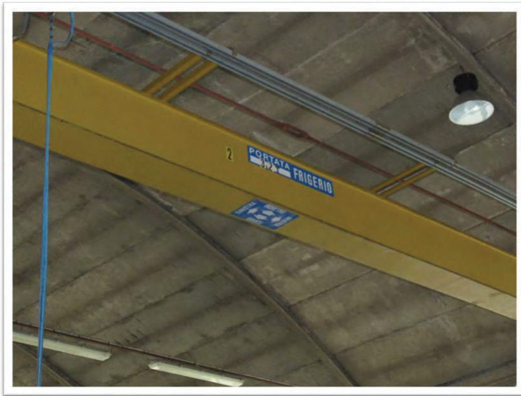
Interni del capannone.
