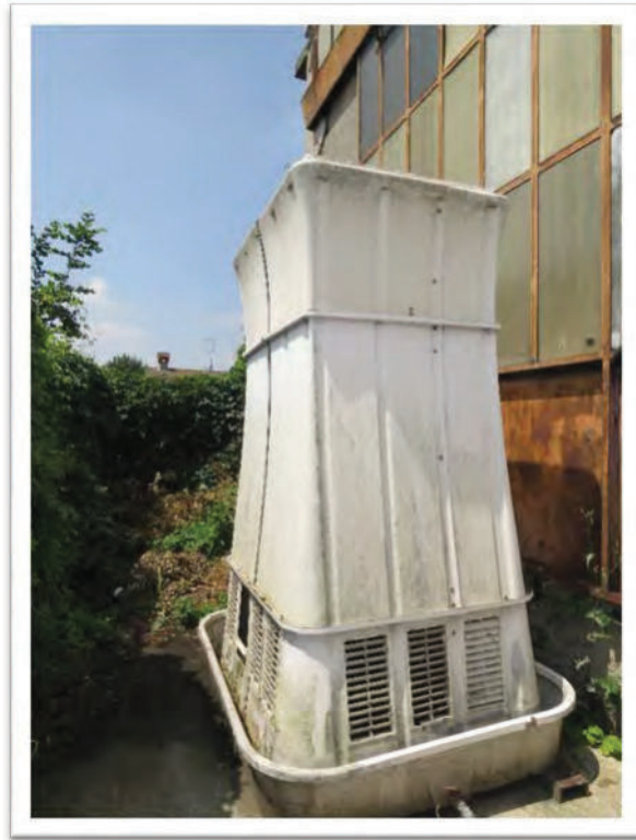
Area esterna / confine Sud.
