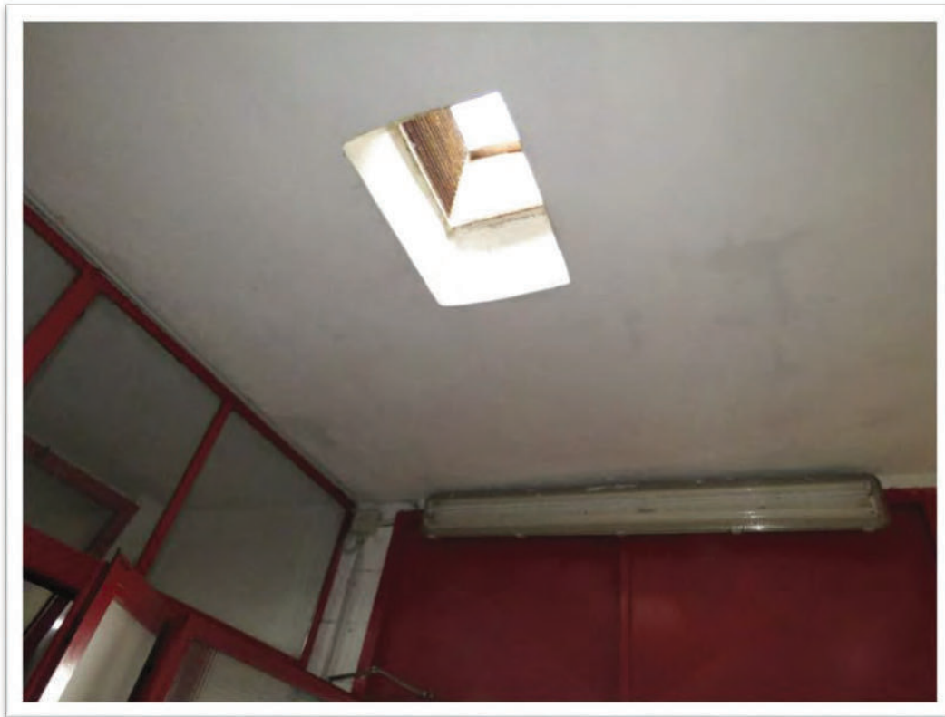
Servizi igienici del capannone.
