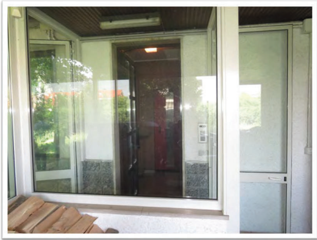
L'ingresso al vano scale che conduce all'abitazione del custode al piano primo.
