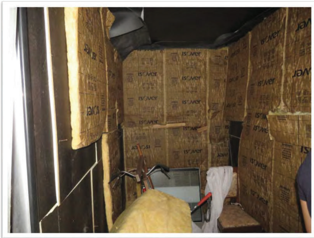
Ripostiglio e ingresso alla cantina.
