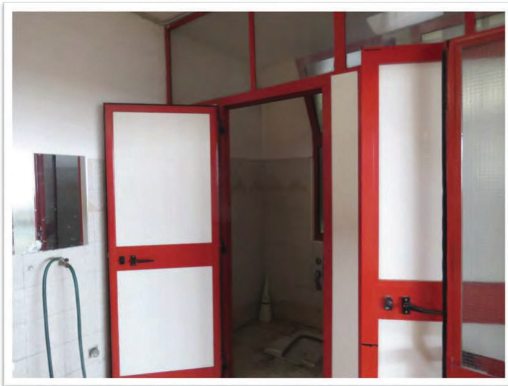
Servizi igienici del capannone.
