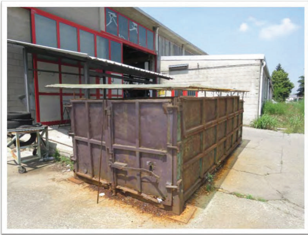
Vasca coperta di cui non è stato reperito il titolo edilizio.
