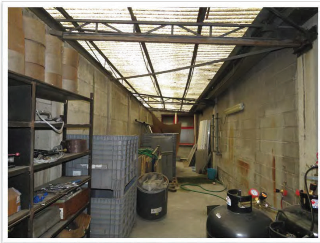
Tettoia posta lungo il confine Ovest di cui non è stato reperito il titolo edilizio.
