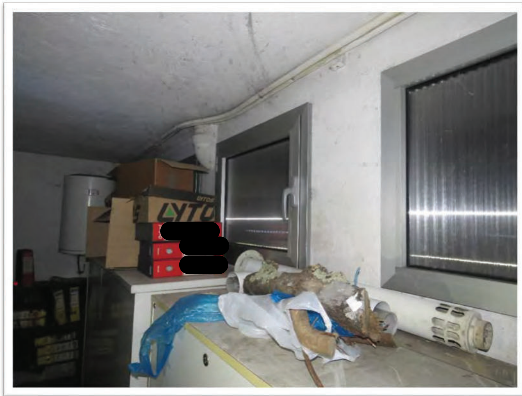
La cantina e la caldaia.
