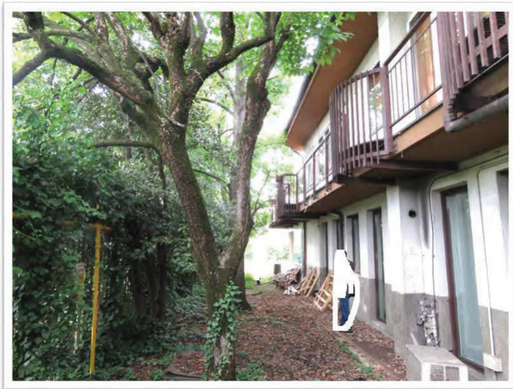
L'area esterna posta verso il confine Ovest.
