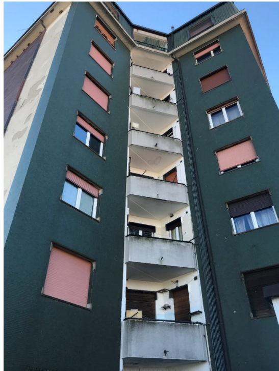
Foto n. 3: Prospetto laterale - Est.
