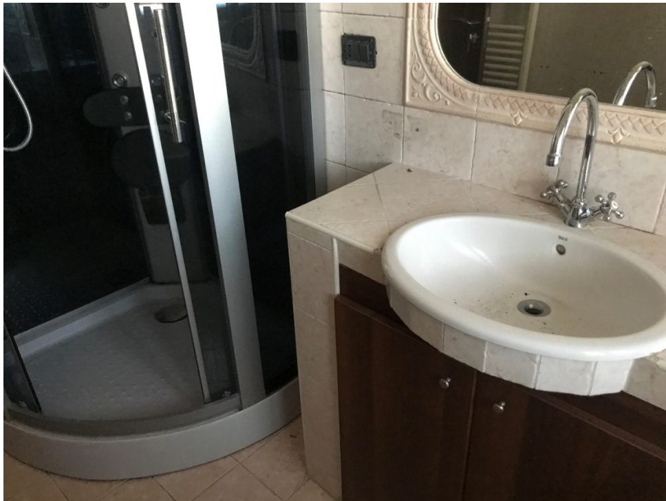
Foto n. 15: Servizio – particolare lavabo.
