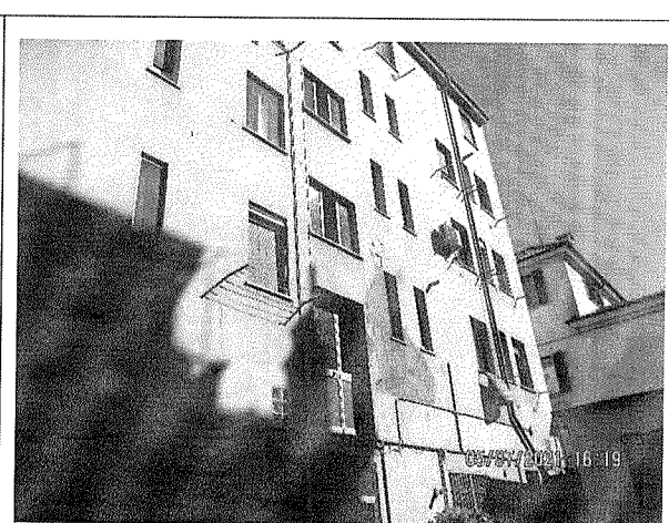
fabbricato- facciata interna
