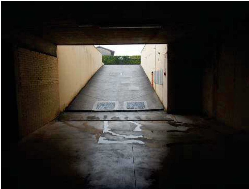
Foto 35-36: Accesso piano interrato e posti auto.
