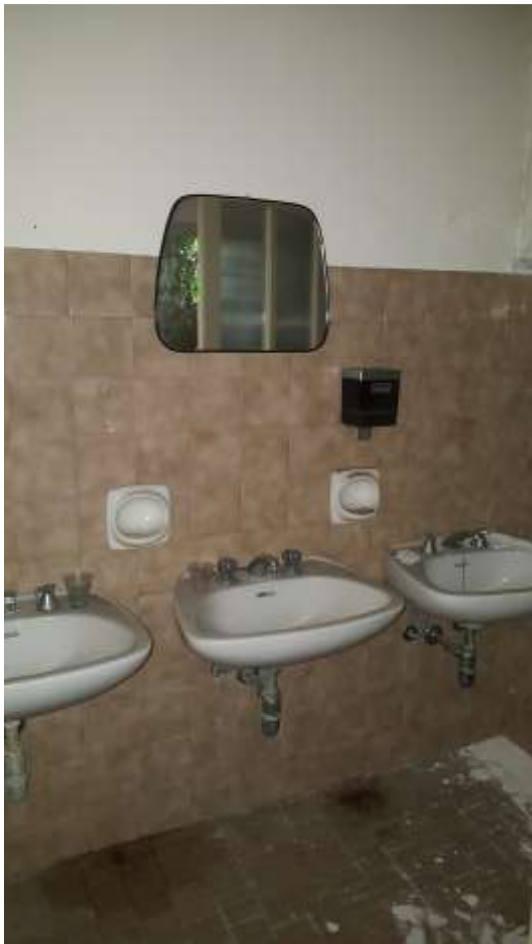
Servizi igienici al piano terra
