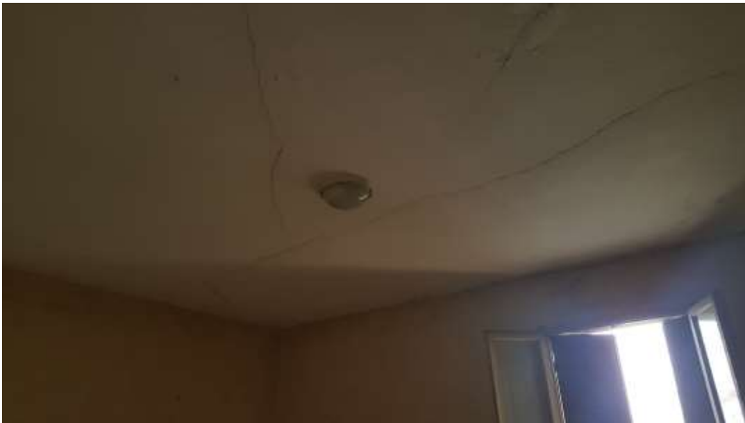
Soffittatura al piano primo
