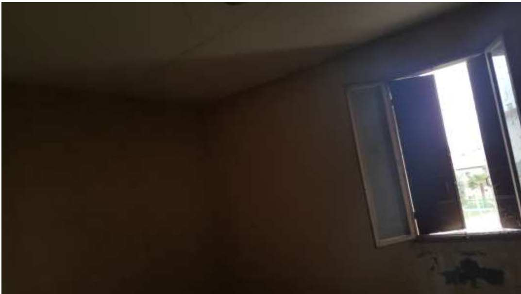
Interni al piano terra
