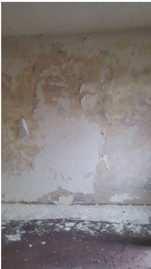
Superfici delle murature al piano terra
