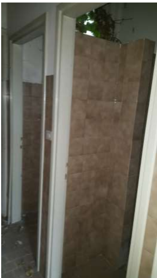
Servizi igienici al piano terra
