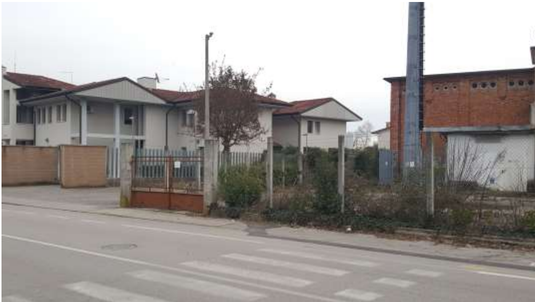
Accesso carraio su via XXV Aprile su cui viene esercitata la servitù di transito
