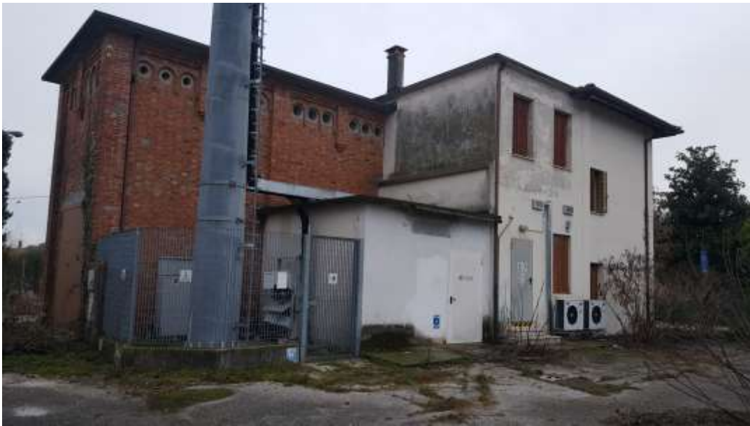
Vista angolo nord-ovest
