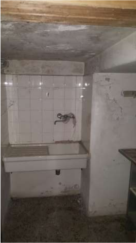
Acquaio al piano terra
