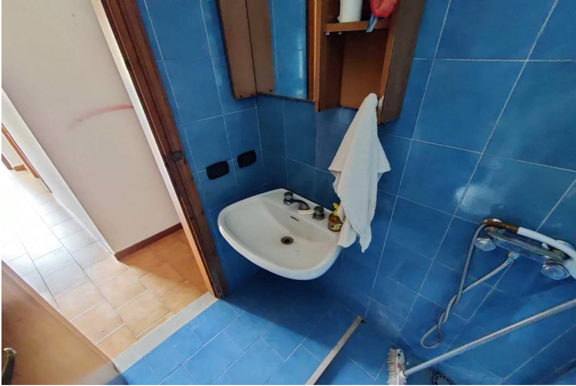
Foto n. 25 – Bagno al pino primo. In evidenza sanitario lavandino e accessori doccia. Stato di conservazione e manutenzione non ottimale.
