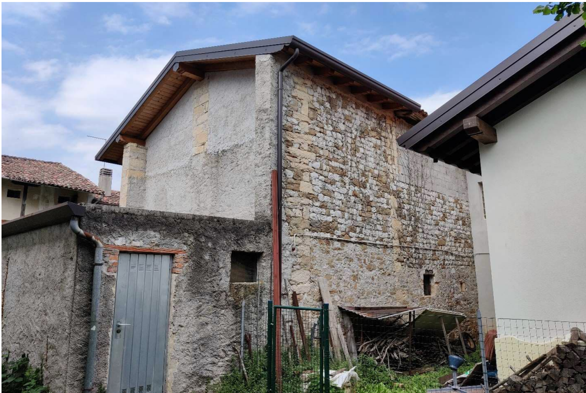
Foto n. 6 – Deposito visto dal retro.
