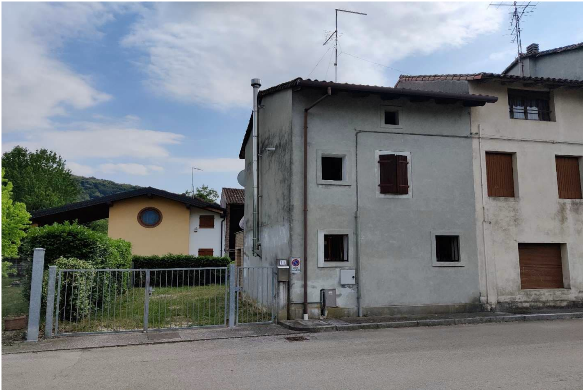
Foto n. 4 – L'immobile visto da via Torrente Meduna (Prospetto rivolto a Nord).
