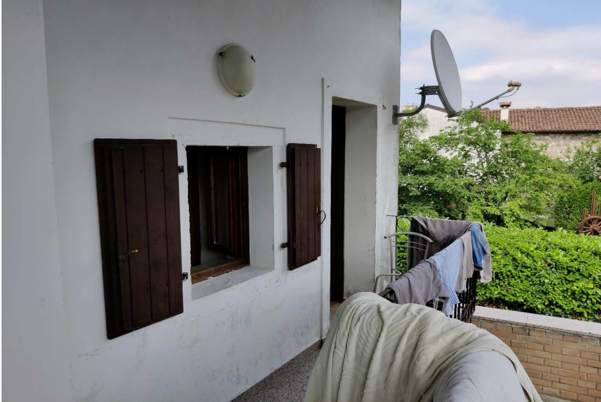
Foto n. 19 – Ballatoio al piano primo, con accesso ai vani interni.
