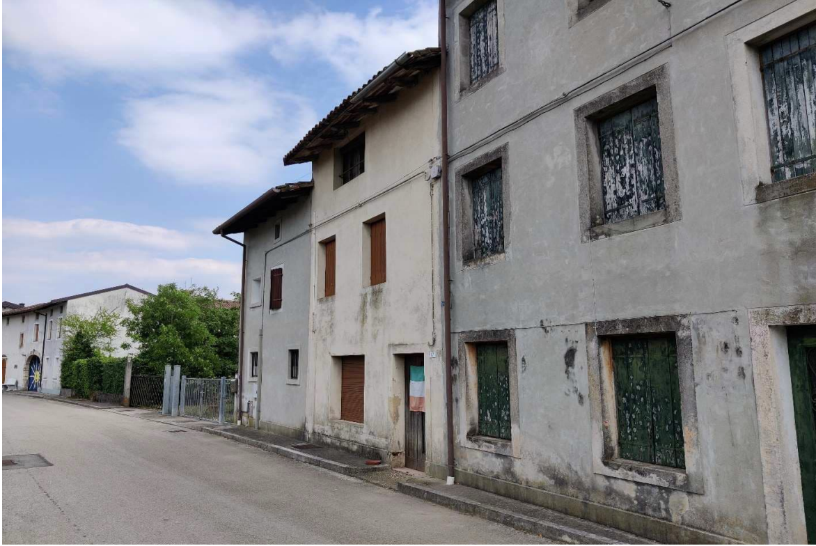
Foto n. 3 – Immobile visto da via Torrente Meduna.
