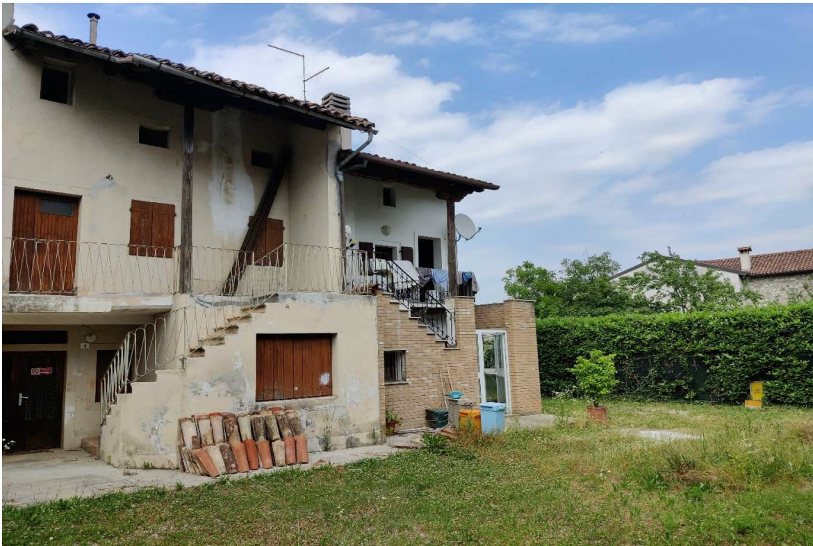
Foto n. 2 – Immobile visto dalla corte interna.
