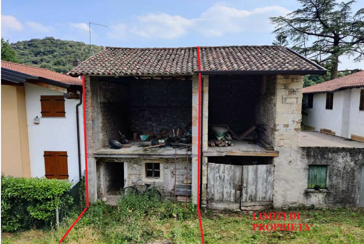
Foto n. 5 – Deposito. In evidenza la porzione di proprietà eseguita.
