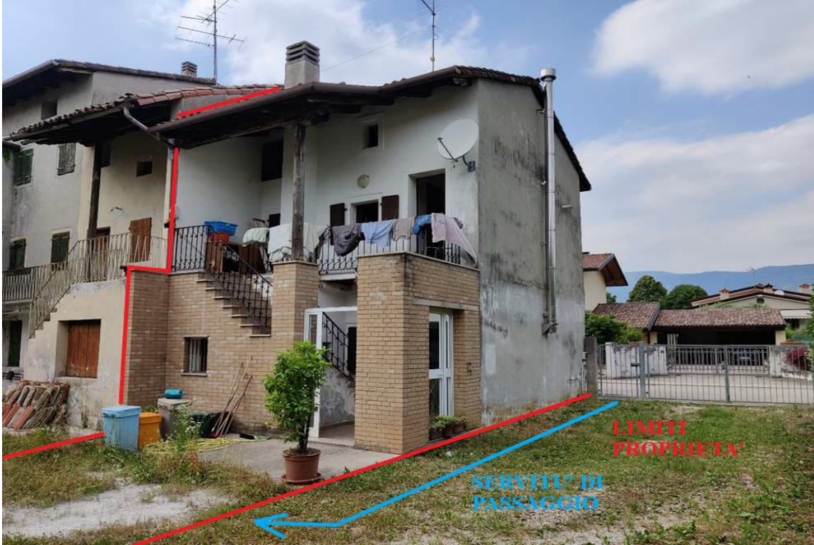
Foto n. 1 – Immobile con delimitati i confini di proprietà e la servitù d'accesso. La cancellata che dà su via Torrente Meduna è su proprietà di terzi.
