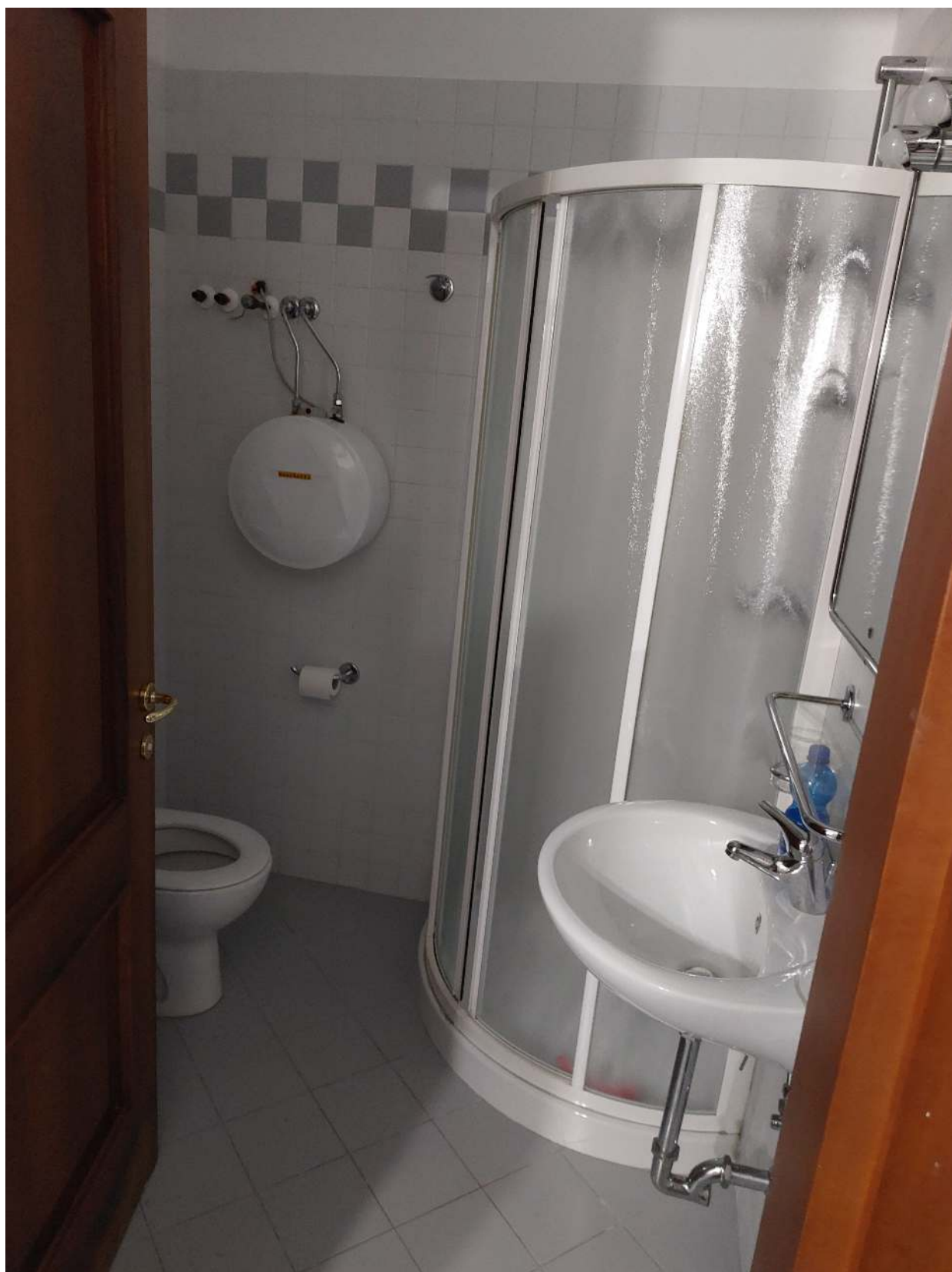
Foto n° 6 - Comune di Porcia, foglio 2, part.291, sub.23 – Locale wc.
