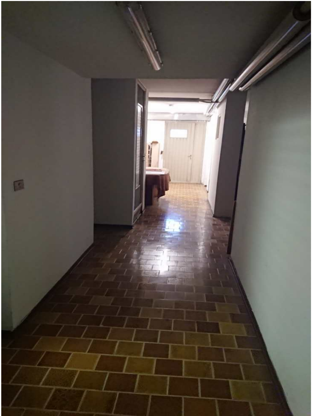
Foto n° 27 - Comune di Porcia, foglio 2, part.293 – Piano scantinato. Disimpegno.
