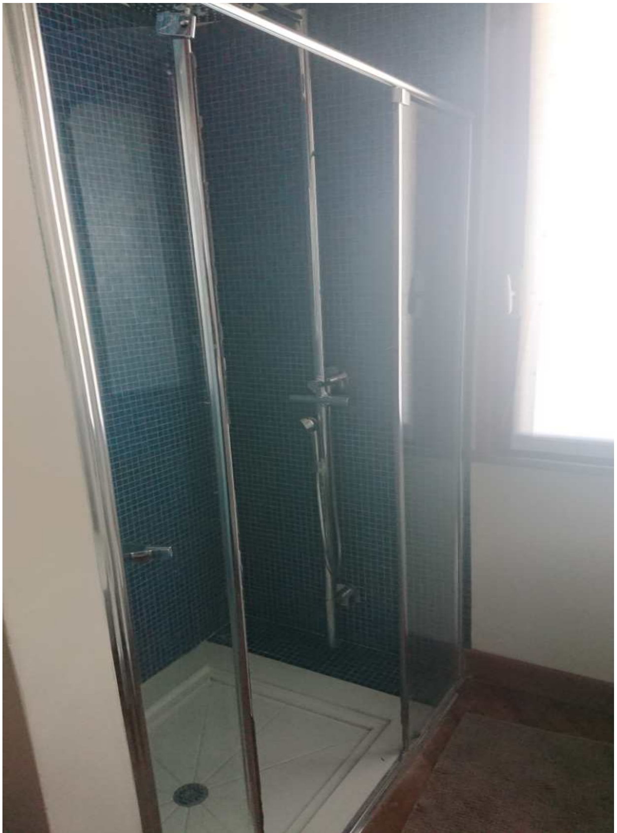
Foto n° 13 - Comune di Porcia, foglio 2, part.293 – Bagno.
