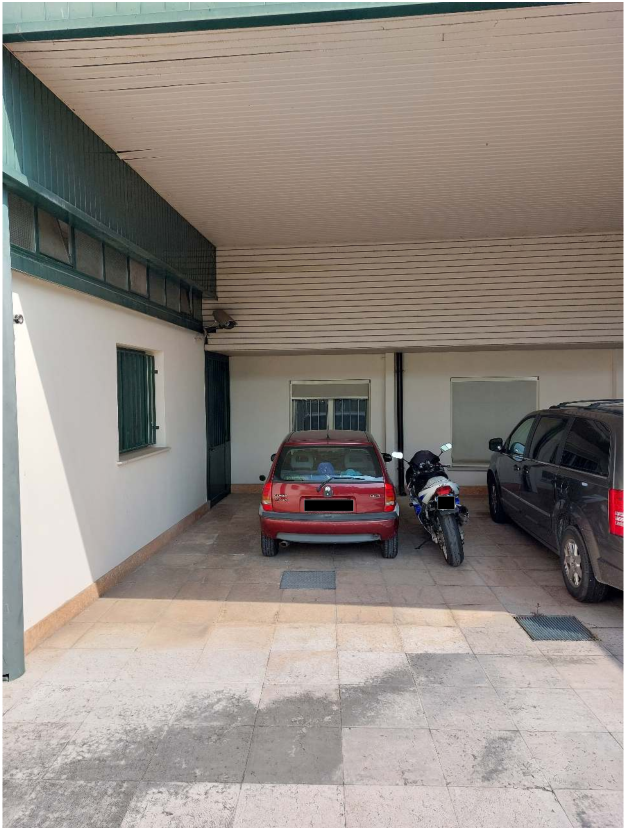
Foto n° 1 - Comune di Porcia, foglio 2, part.612 – Visione del bene pignorato.
