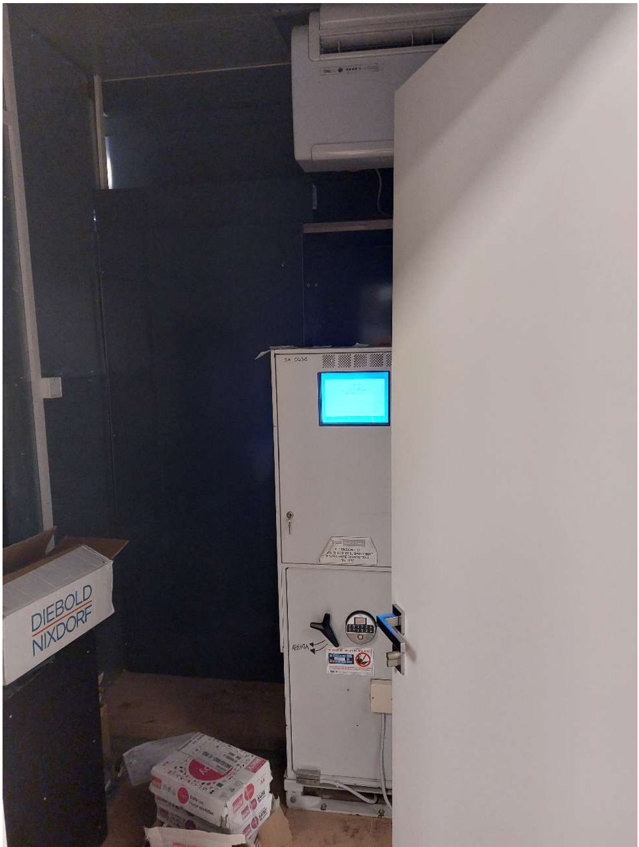
Foto n° 6 - Comune di Porcia, foglio 2, part.291, sub.22 – Locale bancomat.
