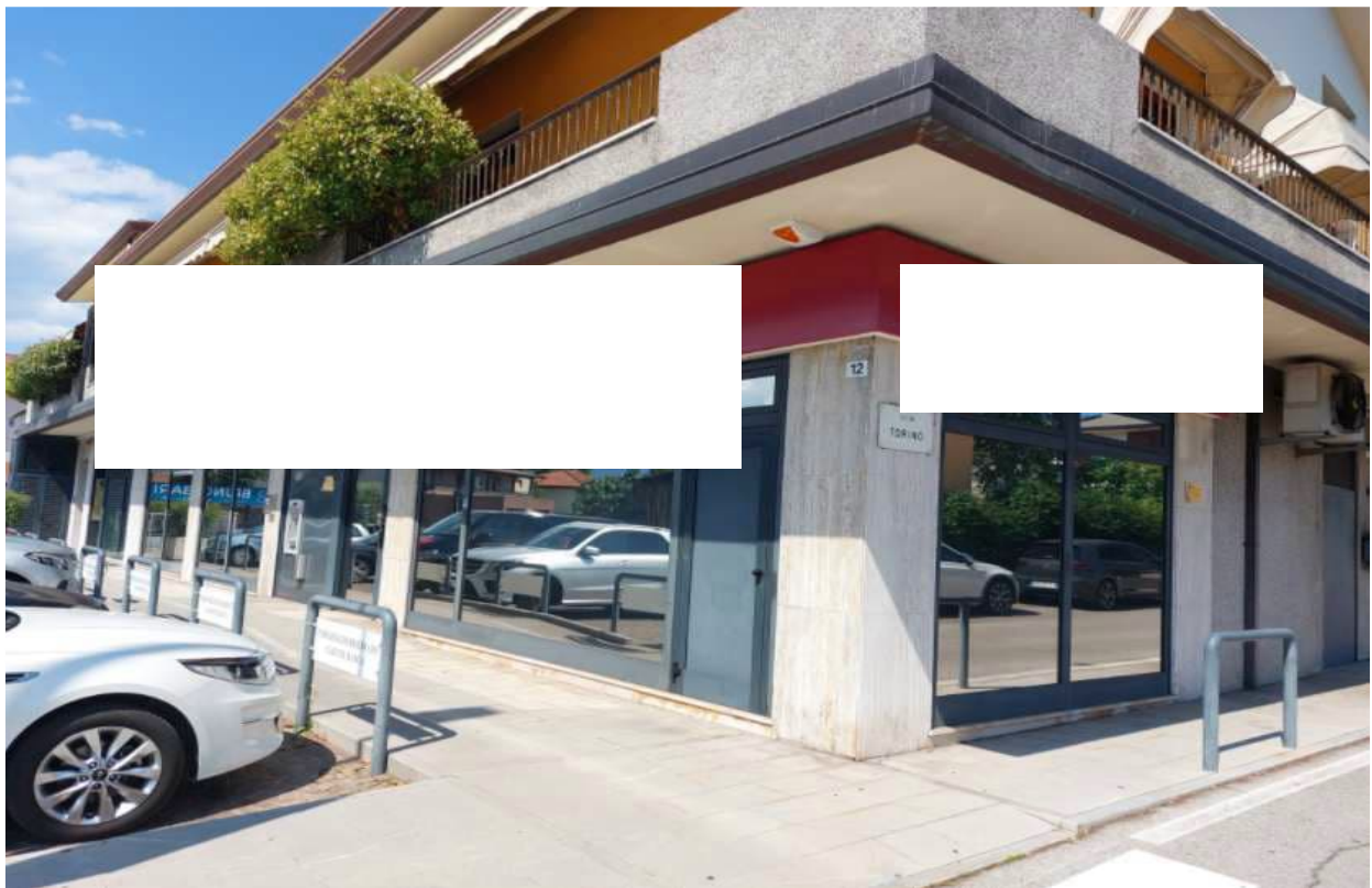
Foto n° 1 - Comune di Porcia, foglio 2, part.291, sub.22 – Visione esterna del bene pignorato.
