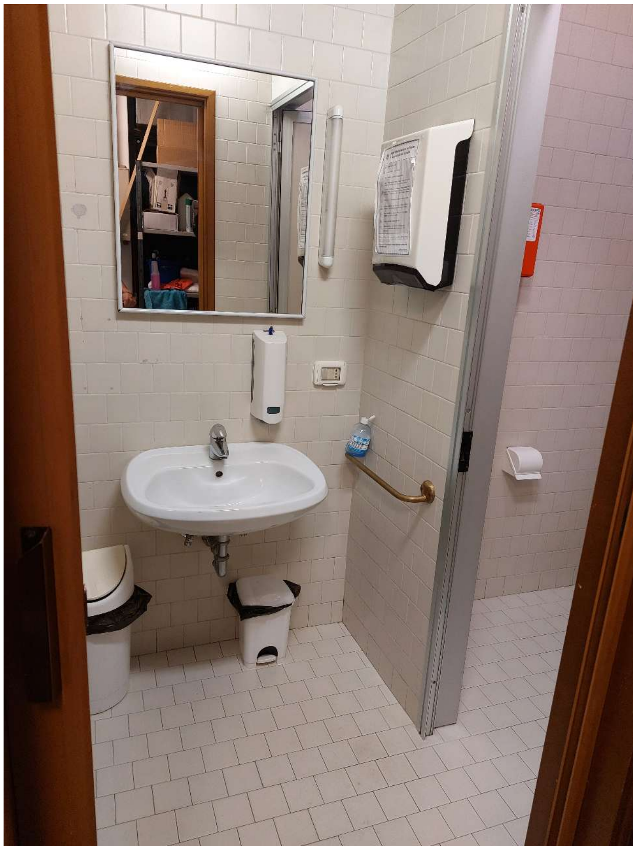
Foto n° 15 - Comune di Porcia, foglio 2, part.291, sub.22 – Anti servizi.
