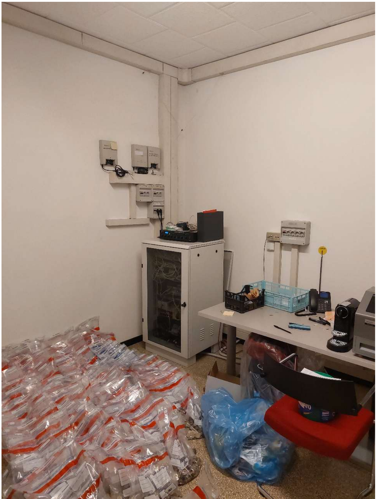
Foto n° 12 - Comune di Porcia, foglio 2, part.291, sub.22 – Archivio.
