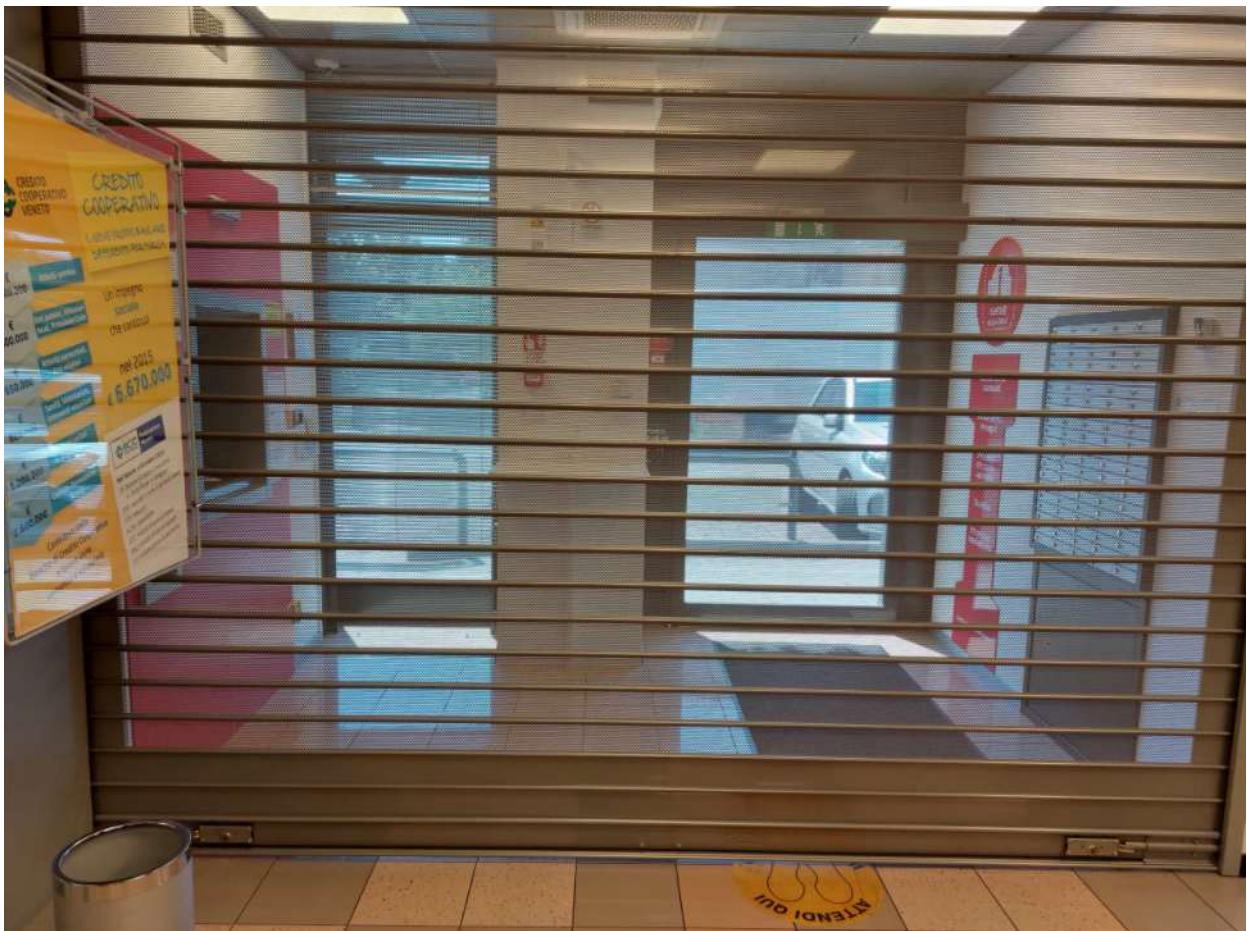
Foto n° 2 - Comune di Porcia, foglio 2, part.291, sub.22 – Accesso principale.
