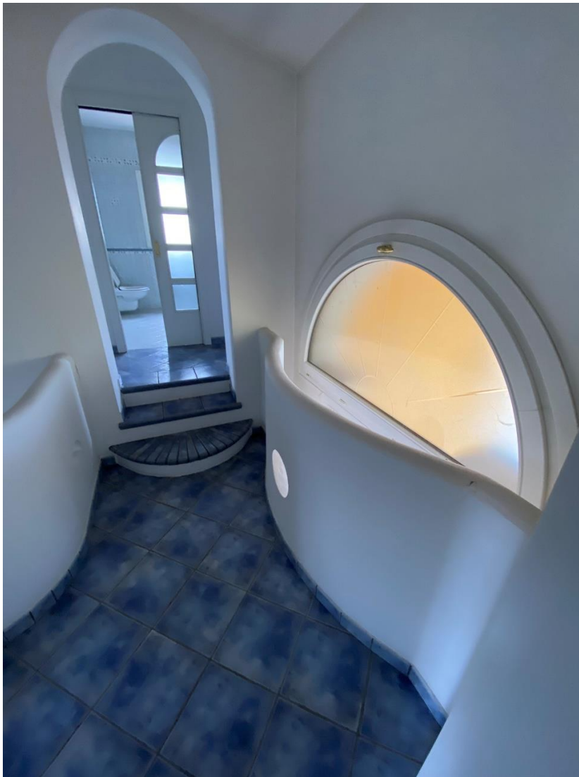
Pianerottolo al piano primo
