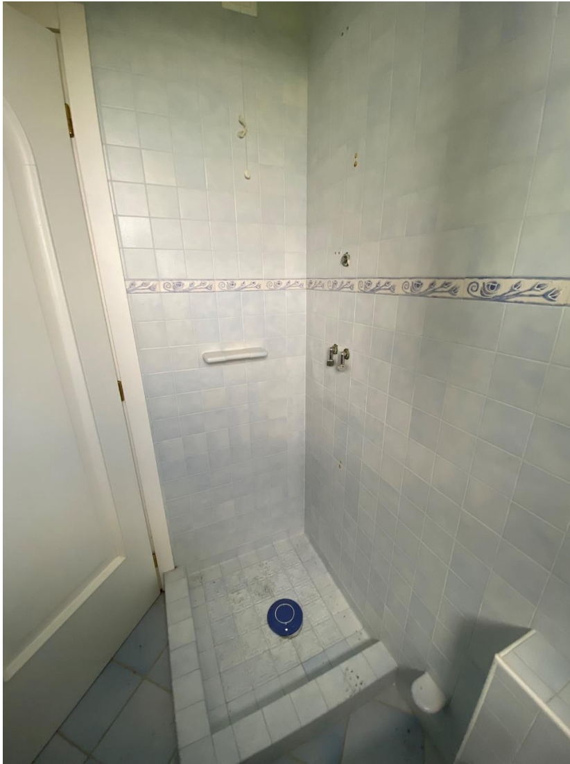
Il bagno al piano terra
