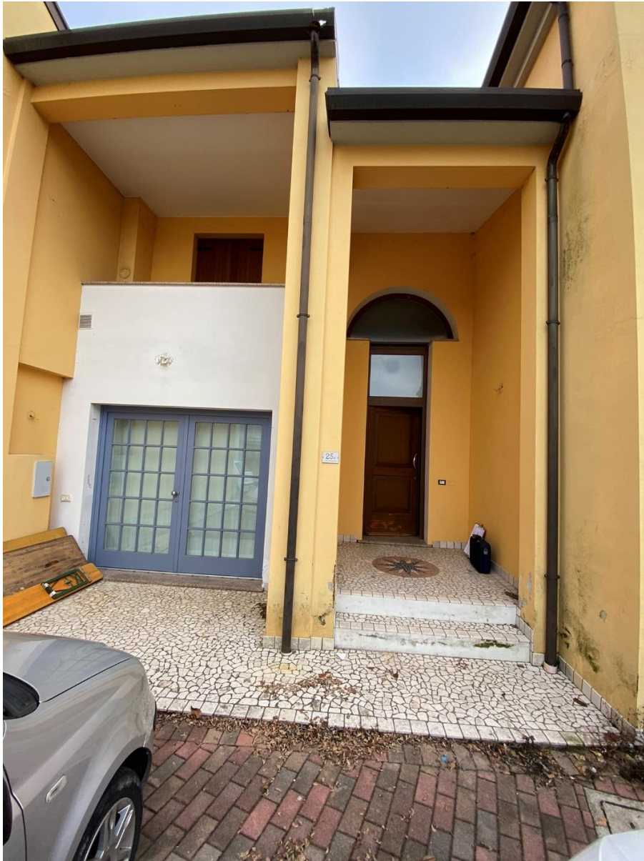
L'ingresso principale all'abitazione e l'ingresso all'autorimessa
