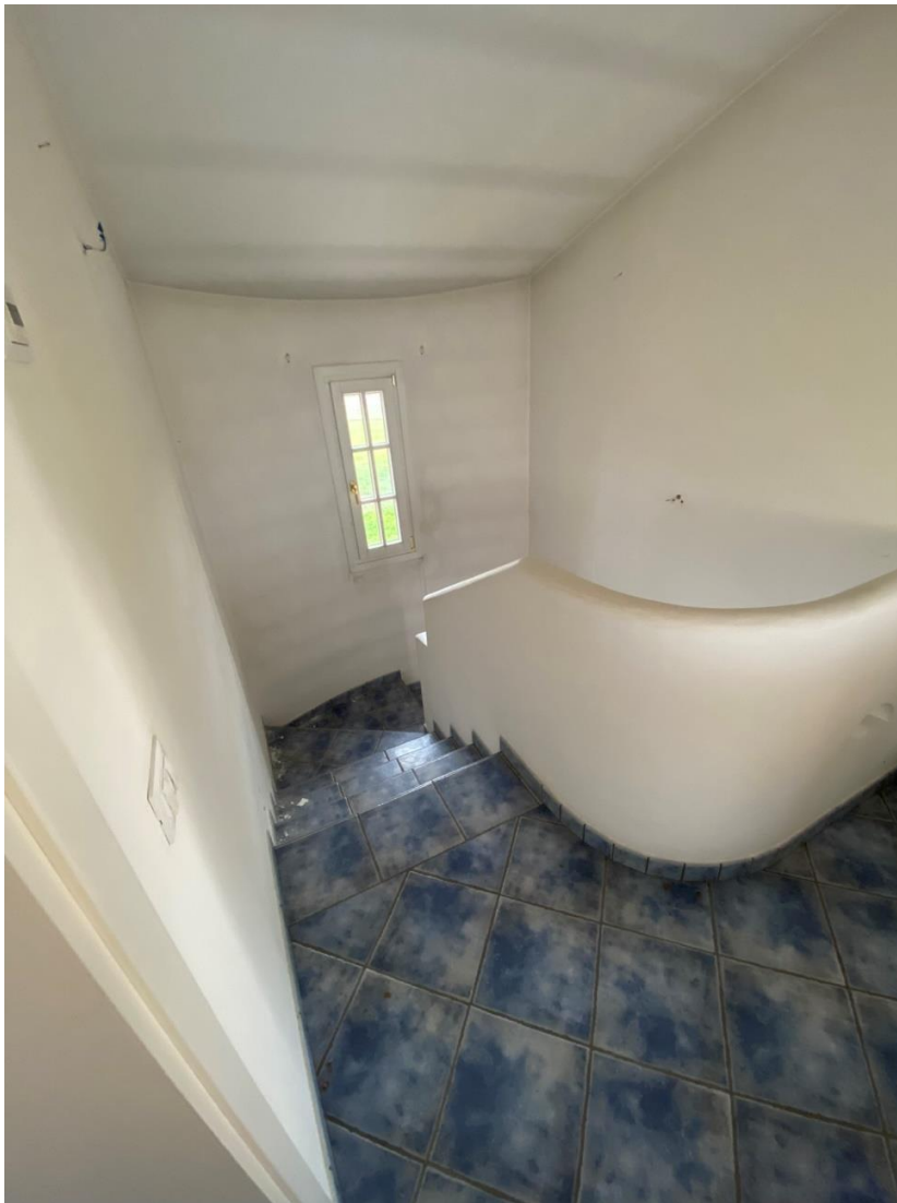
Arrivo della scala al piano primo
