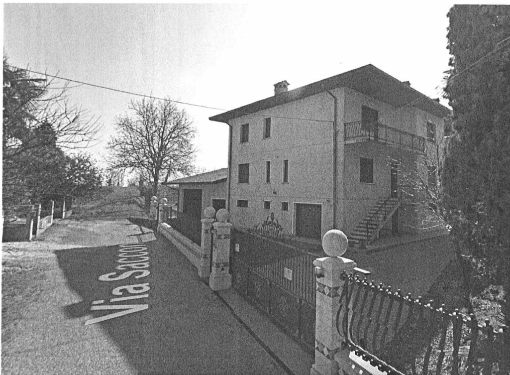
3. Particolare: vista fronte strada
