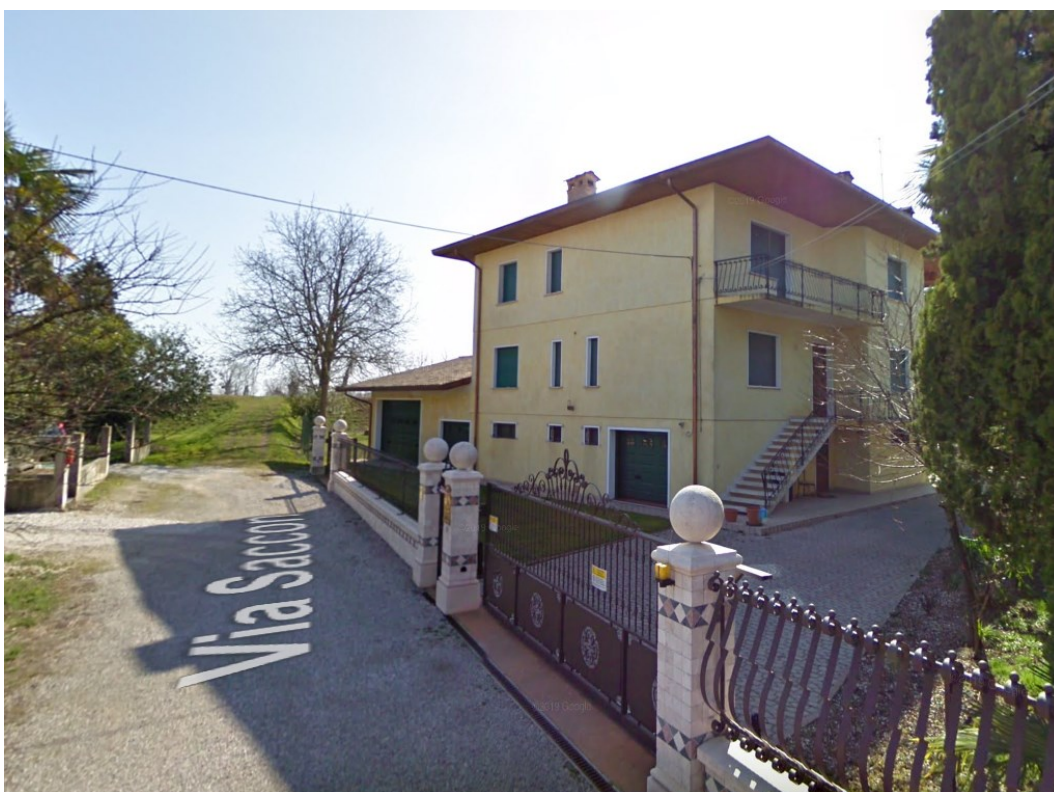
3. Particolare: vista fronte strada
