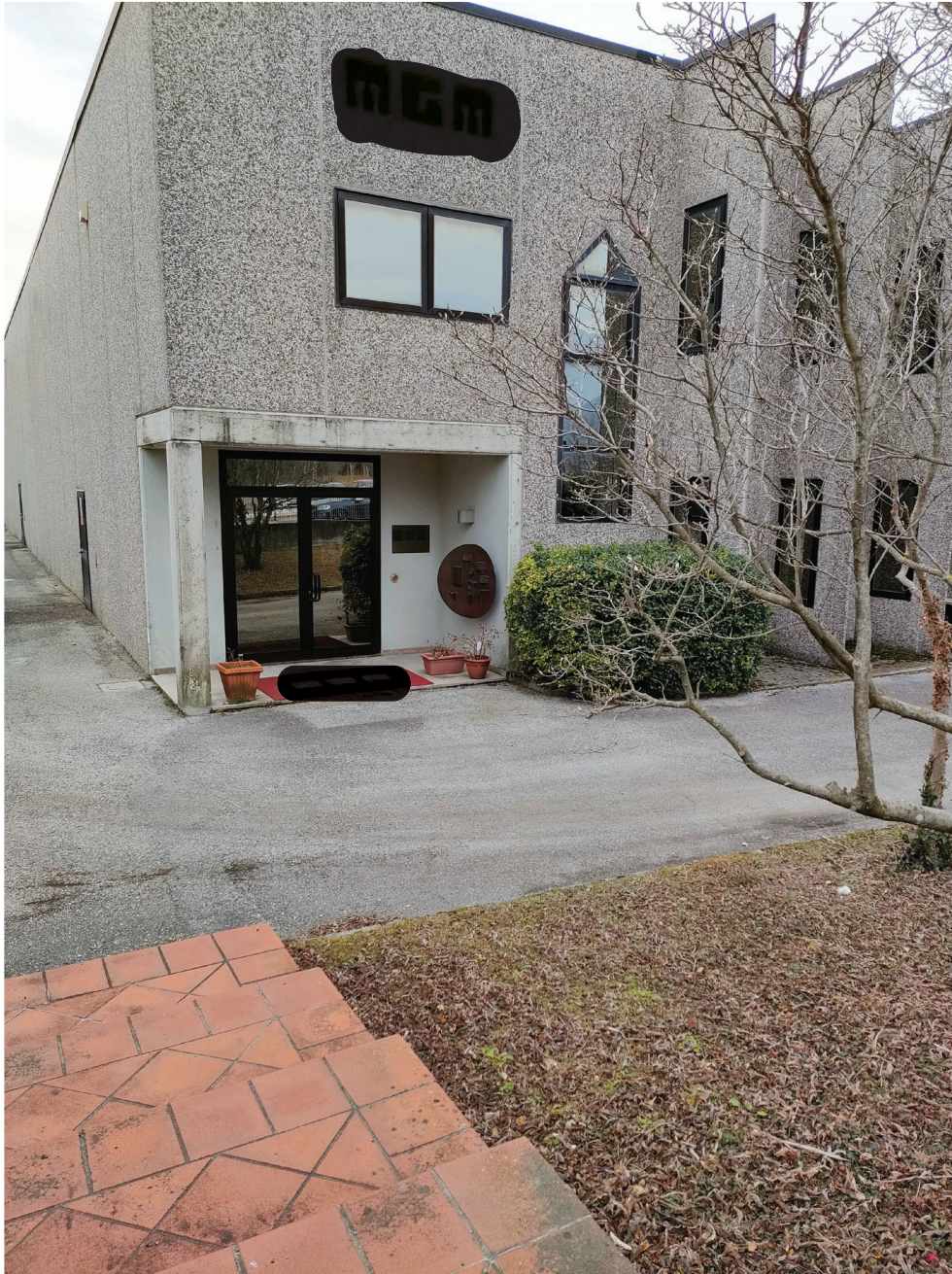
5. Foto: ingresso uffici
