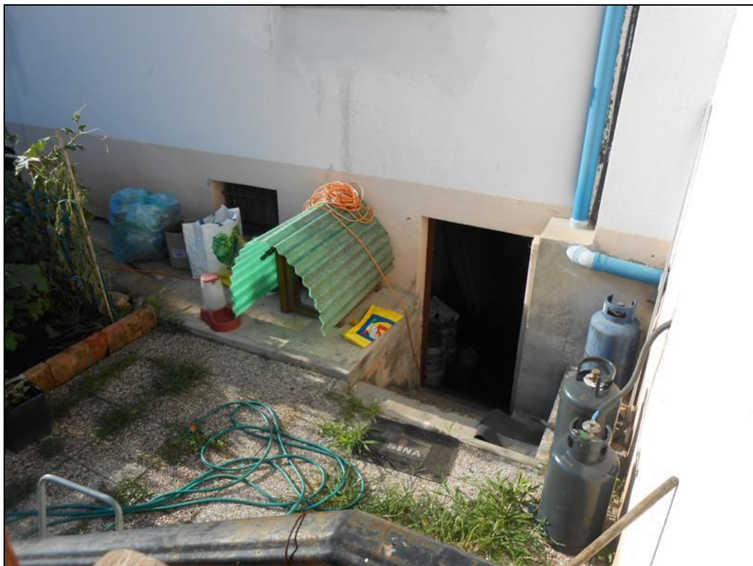
Scala di comunicazione con lo scoperto
