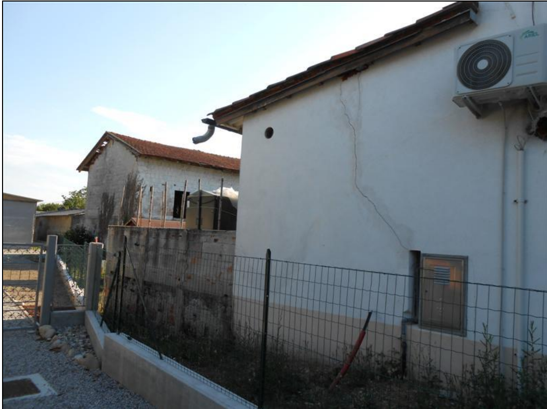
Recinzione sul lato est del complesso e veduta del fabbricato deposito
