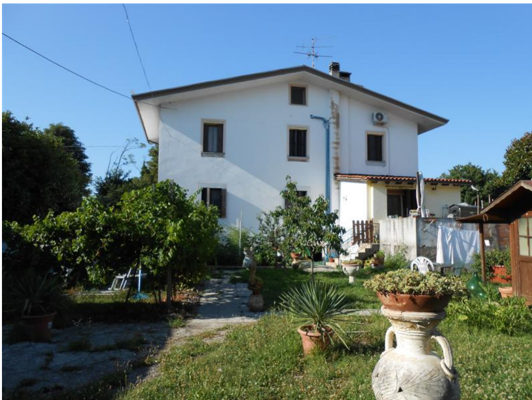
Fronte sud del fabbricato abitazione e veduta dello scoperto
