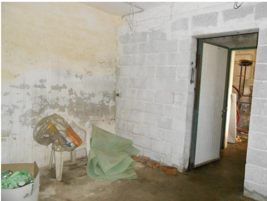
Cantina e disimpegno
