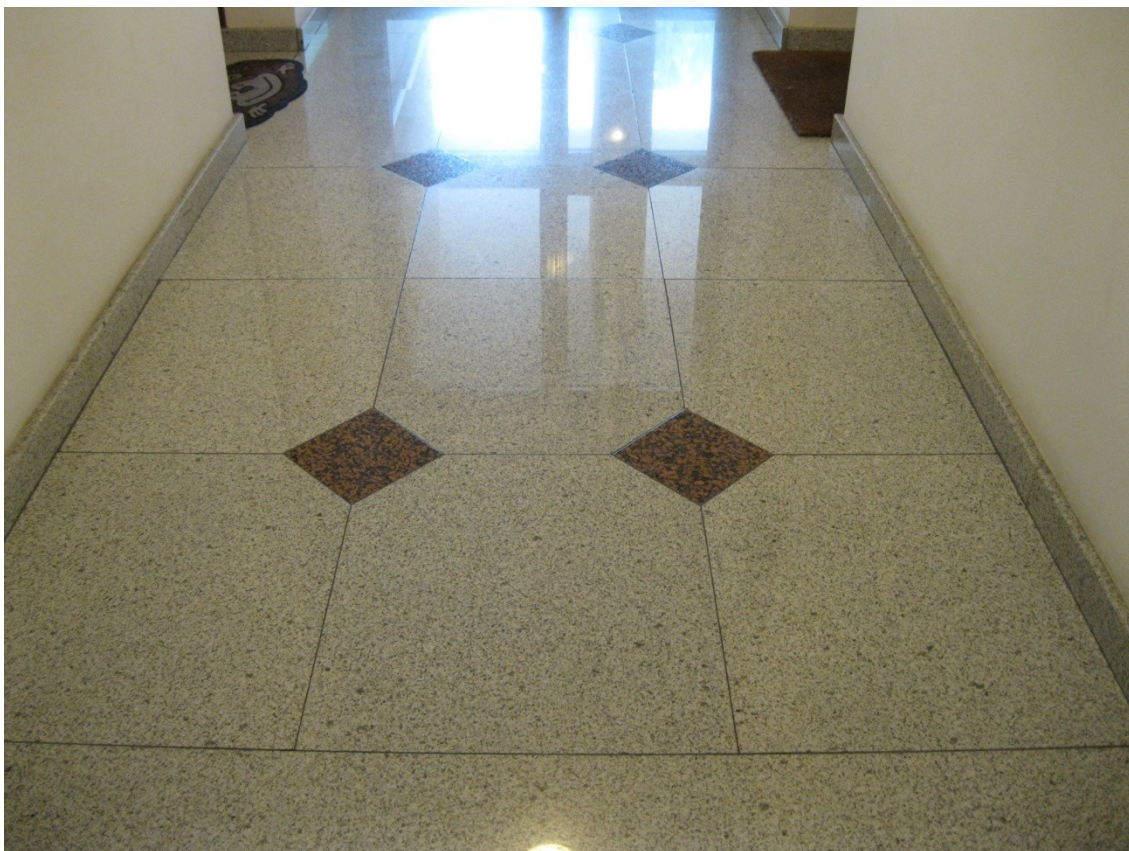
Foto 4 Dettaglio pavimentazione atrio condominiale
