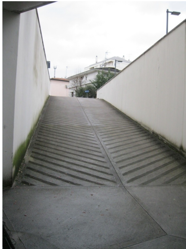
Foto 21 Rampa carrabile accesso garages
