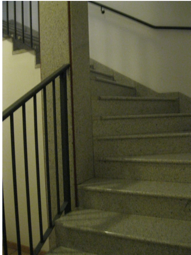
Foto 18 Scala di collegamento ai garages
