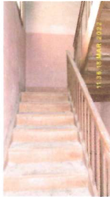
SCALA DA PIANO PRIMO A PIANO SECONDO
