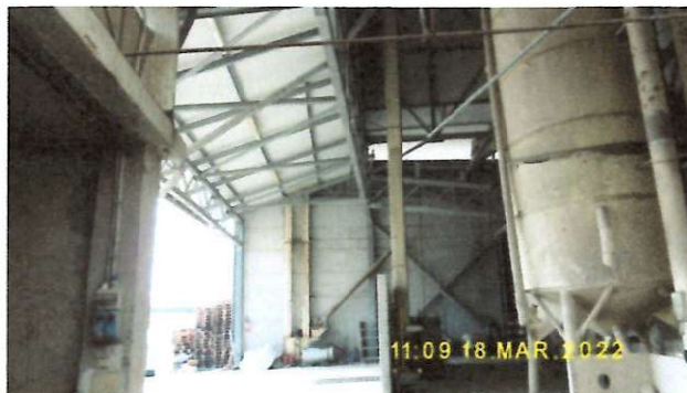
TETTOIE E SILOS
