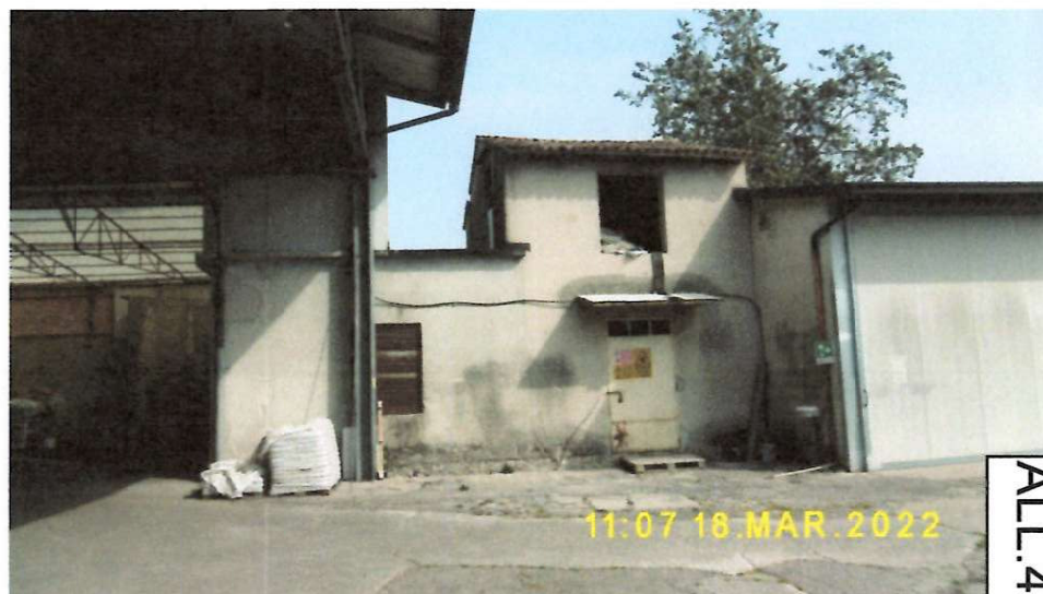
VISTA SUD-EST MAGAZZINI
