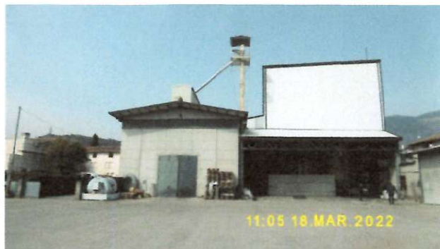
VISTA SUD-EST TETTOIE
