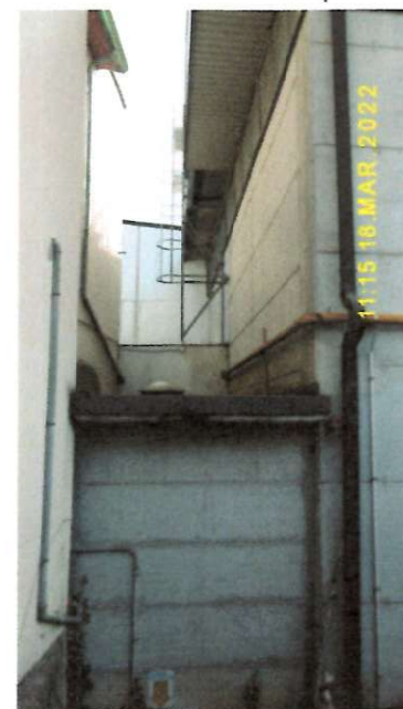
VISTA NORD-OVEST DEPOSITO
