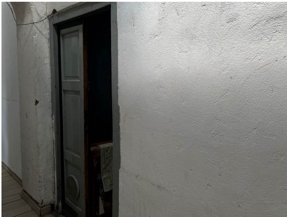
Fotografia n. 14 – Vista della porta di ingresso all’immobile oggetto di pignoramento (locale camera)
