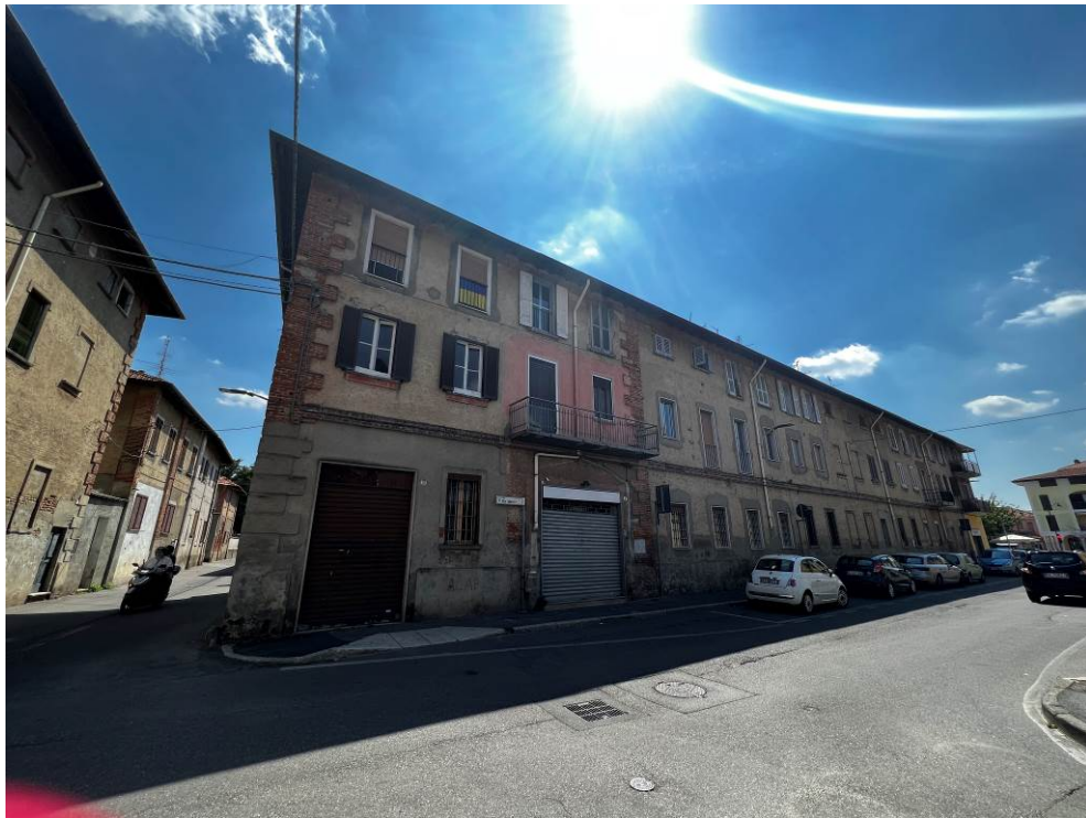
Fotografia n. 1 – Vista del prospetto del fabbricato su Via dei Martiri, su cui affaccia l'immobile oggetto di pignoramento (locale camera)
