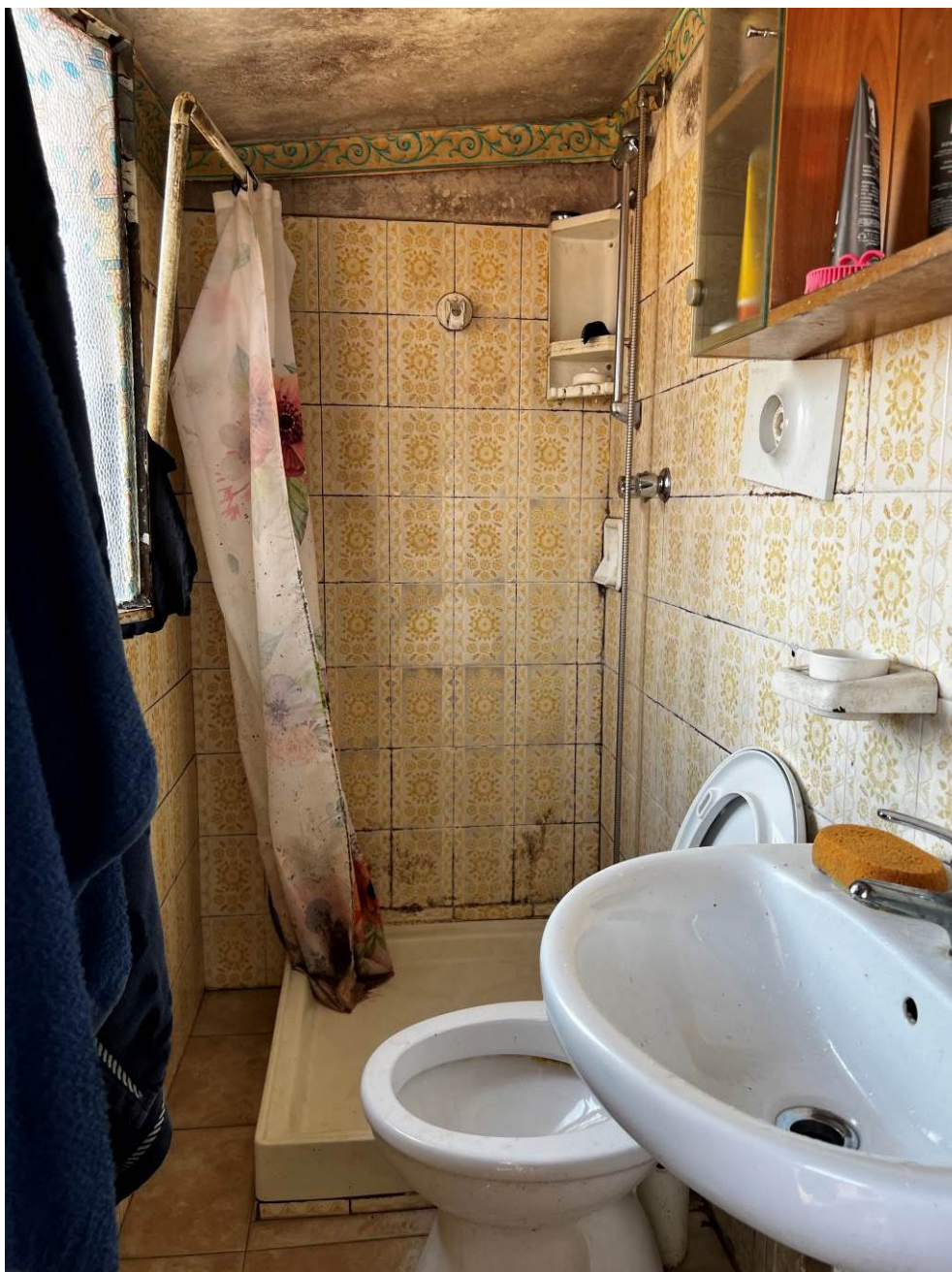
Fotografia n. 28 – Vista del locale bagno
