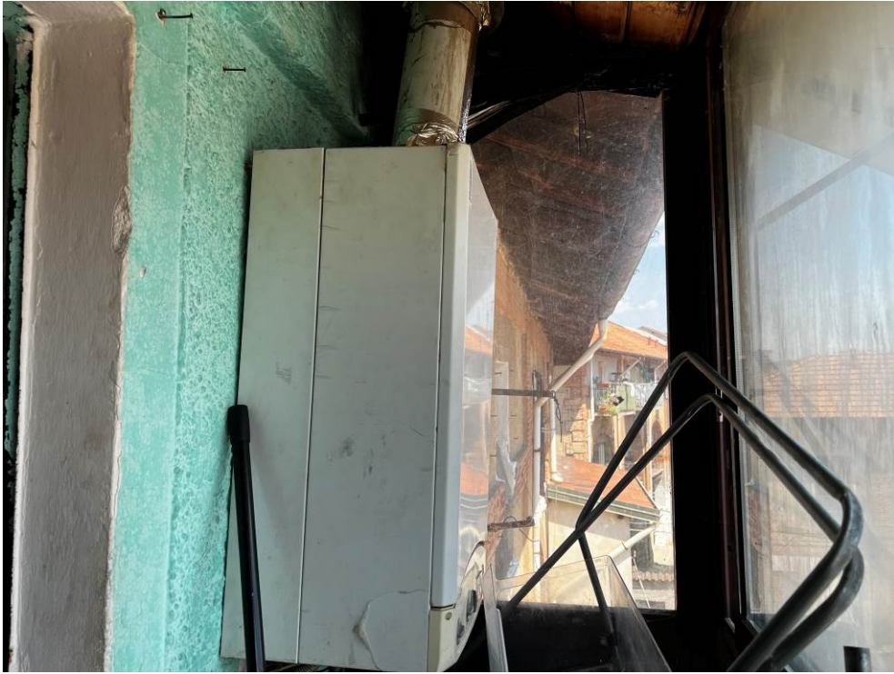
Fotografie n. 26/27 – Particolari della caldaia sul balcone – Mod. Baxi – a servizio dell'immobile
