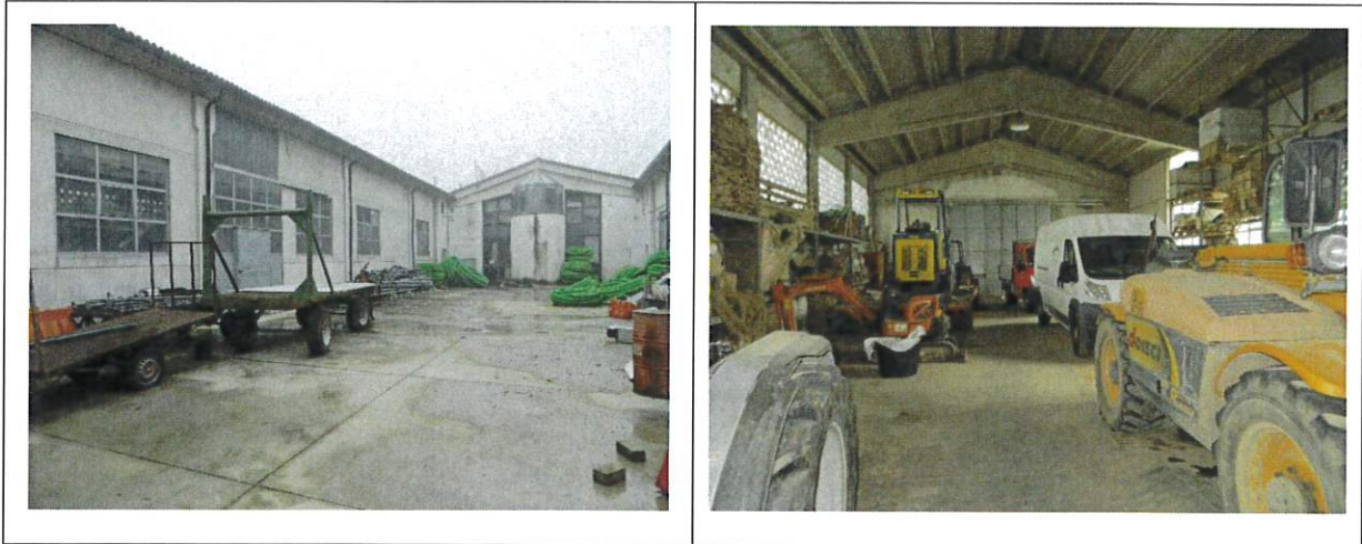
Corpo C cortile interno
