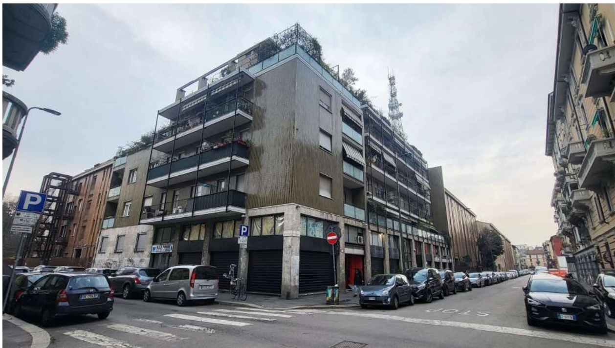
Edificio in Milano (MI), Via Marco Aurelio n. 42
