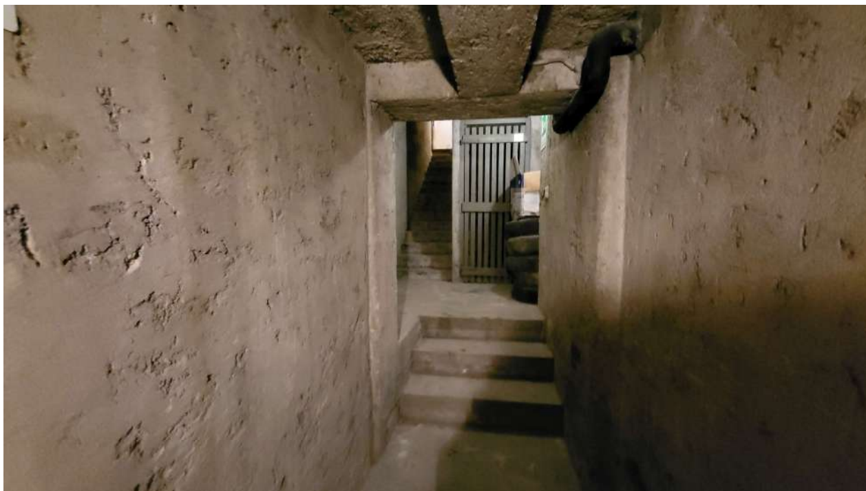
Scala di accesso alle cantine
