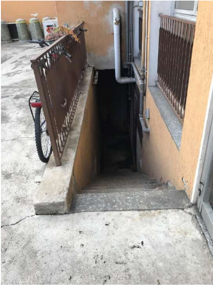
Scala di accesso alle cantine dal cortile
