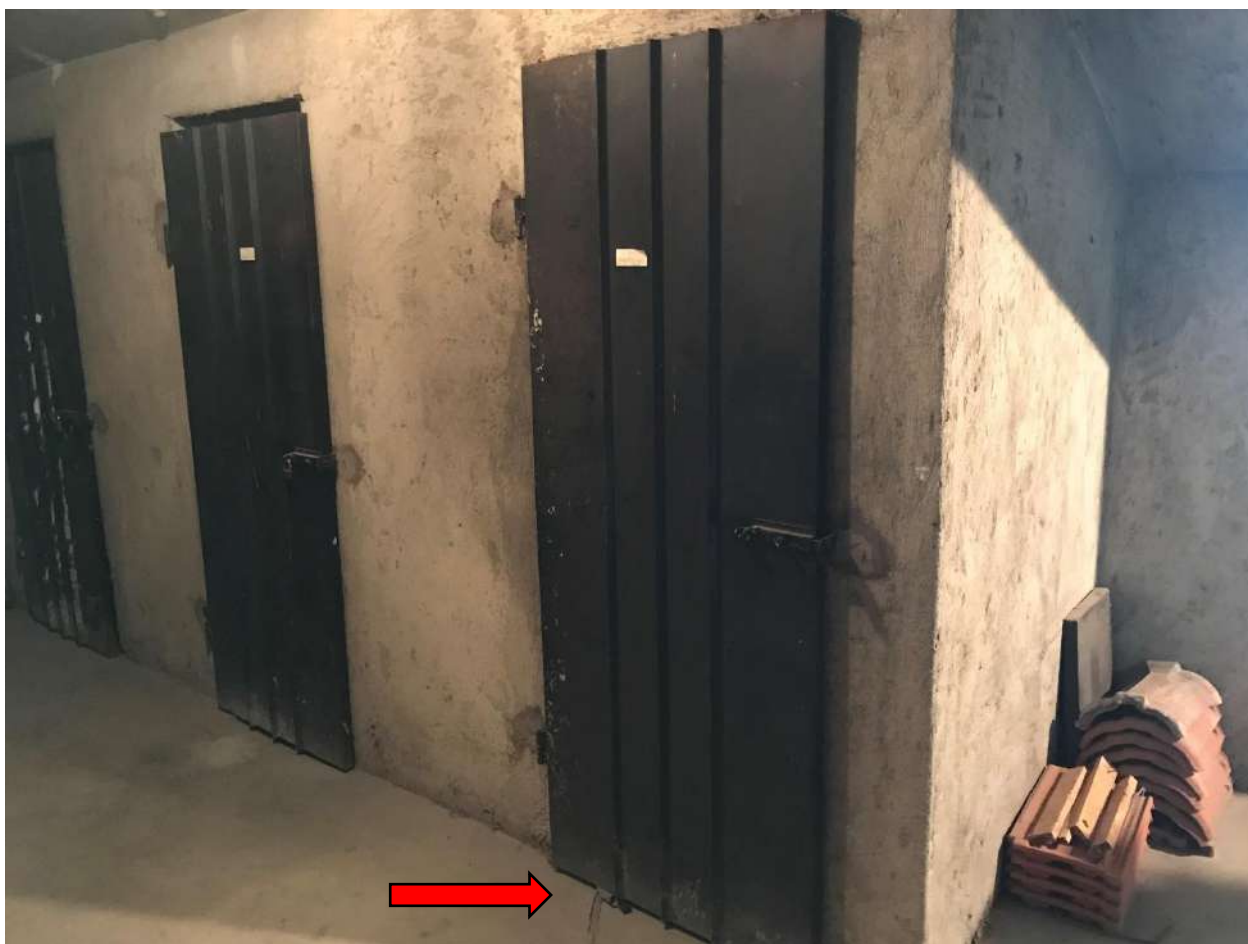
Solaio di pertinenza
