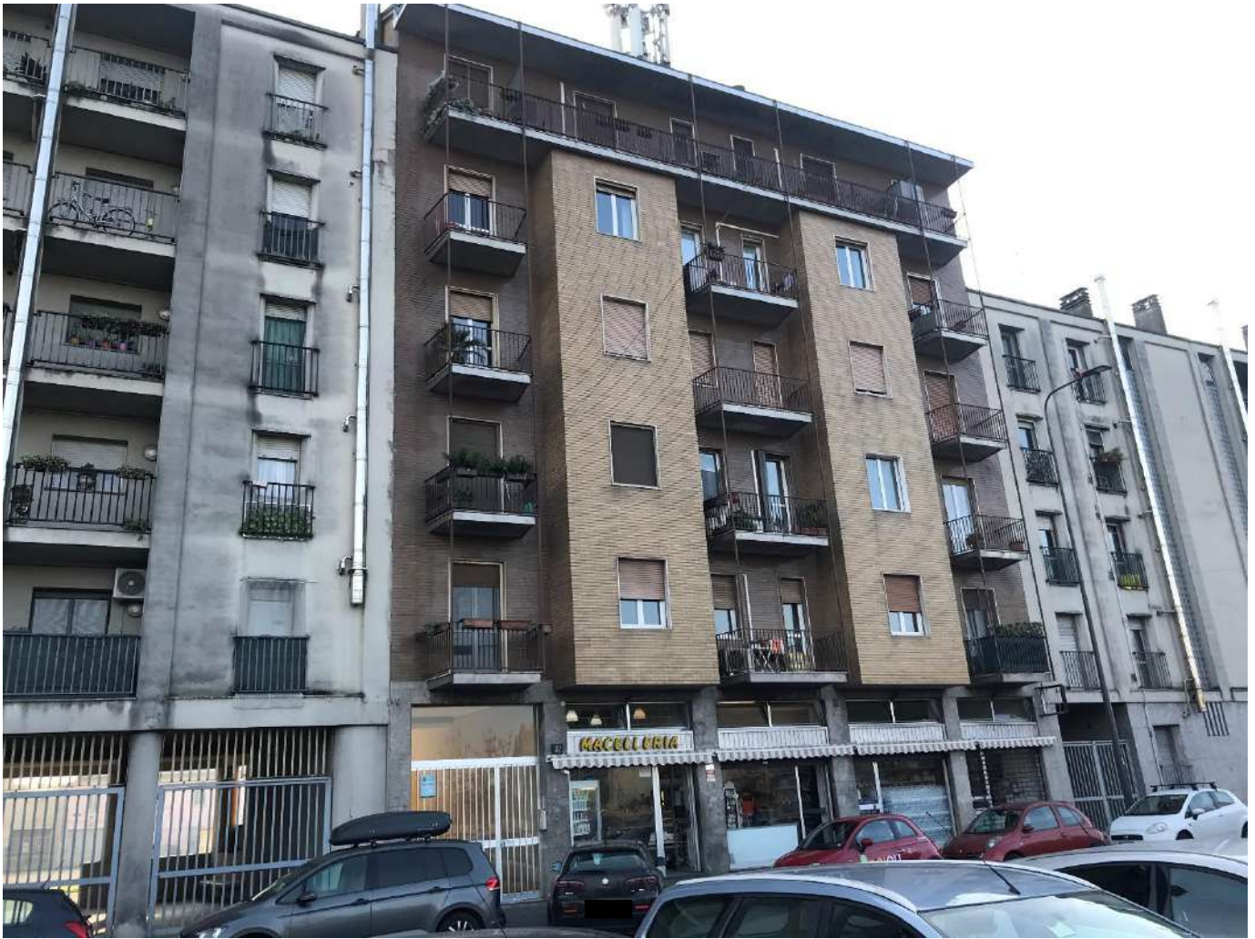
Edificio di Via Vittorini 32
