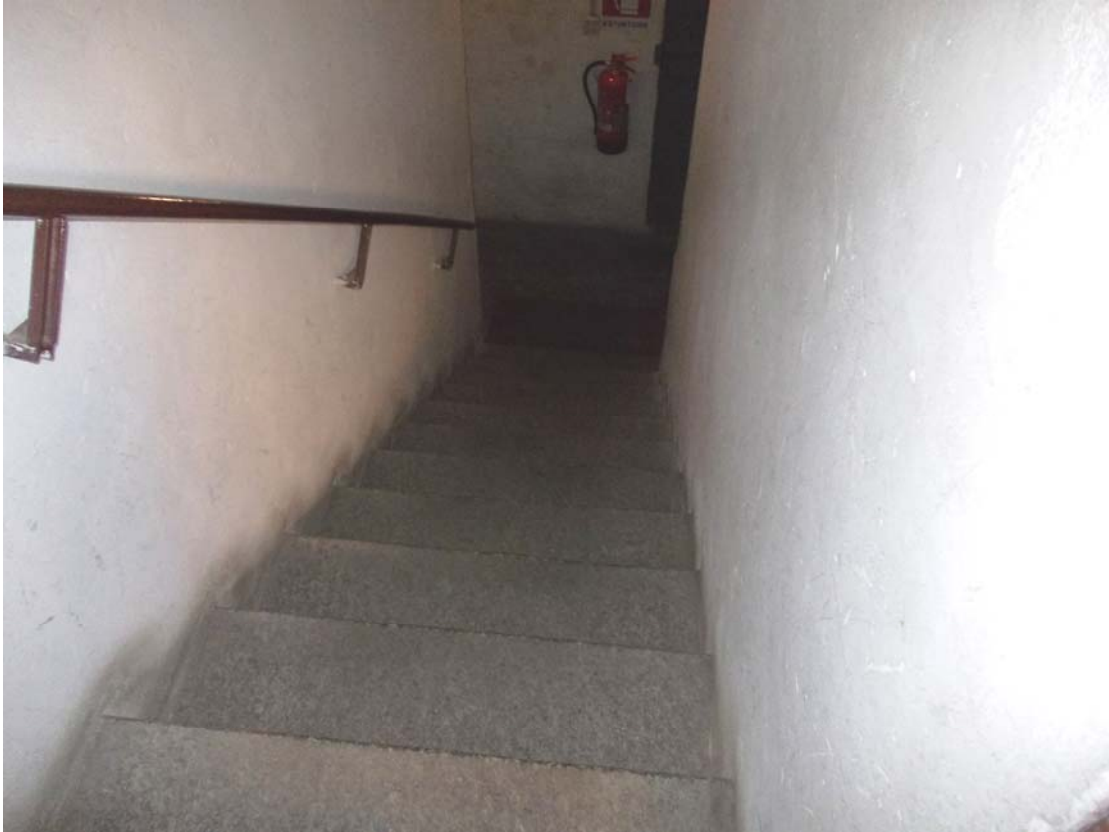
Scale di accesso alle cantine
