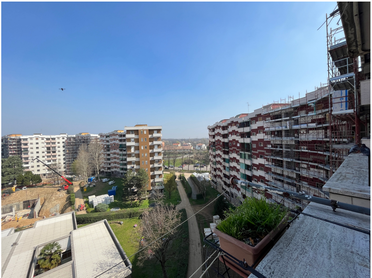
Immagini 13 e 14. Vista del giardino condominiale tra i diversi fabbricati attualmente interessato dai lavori di efficientamento (sostituzione centrale termica).
