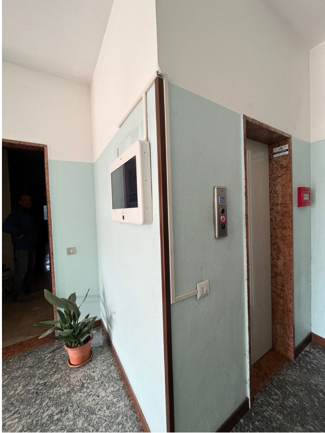
Immagine 5. L'ascensore che parte dal livello rialzato.
