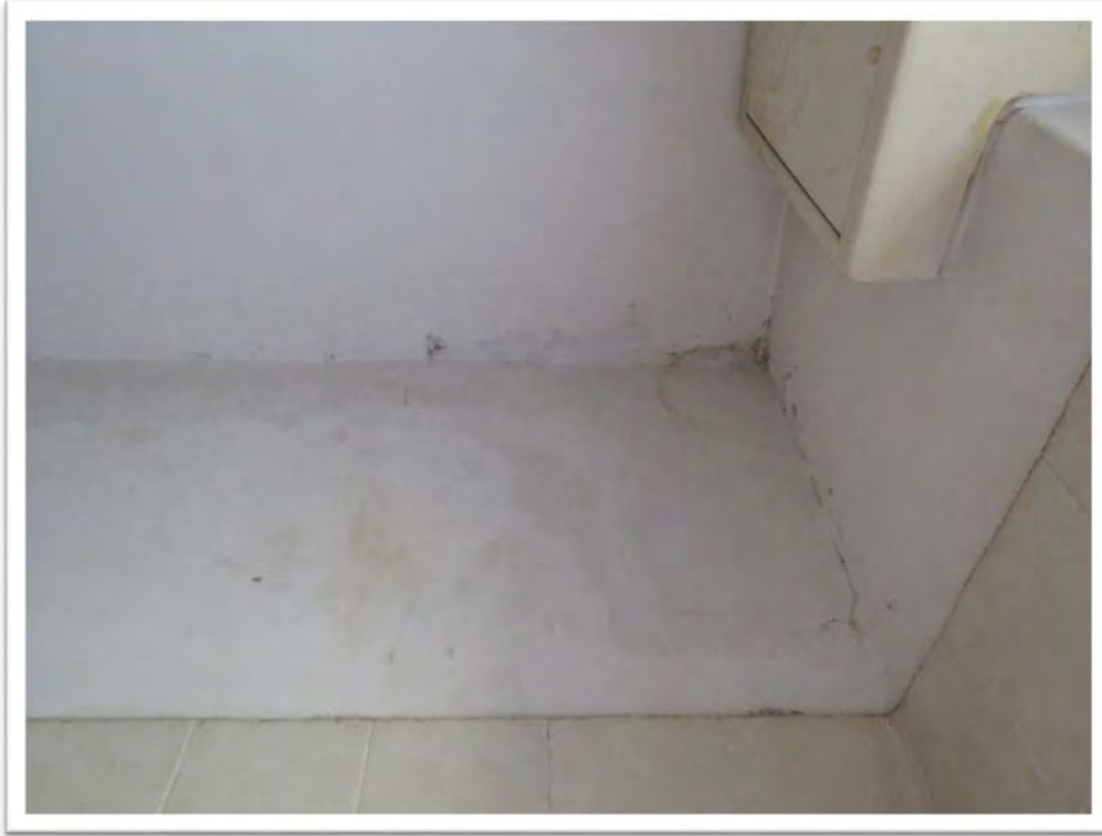
Particolari del bagno.
