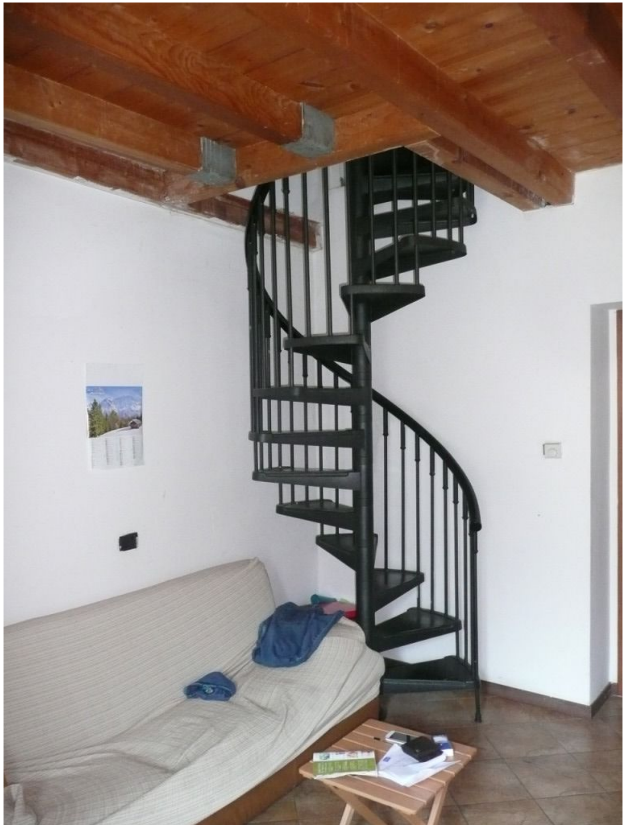
SCALA DI COLLEGAMENTO AL PIANO SOTTOTETTO
