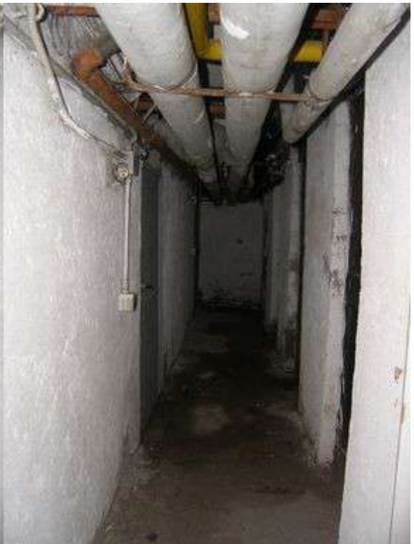
Vista corridoio piano cantinato
