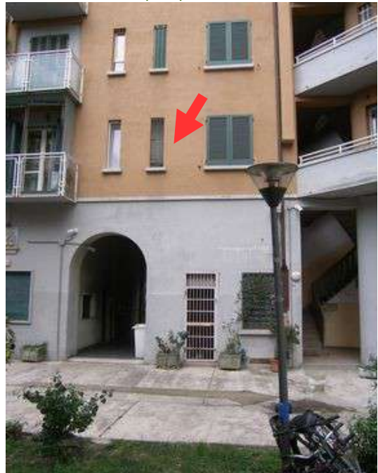
Vista vano scala
