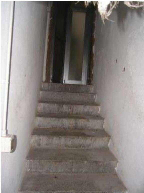
Vista scala accesso piano cantinato
