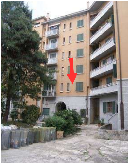
Vista androne di ingresso
