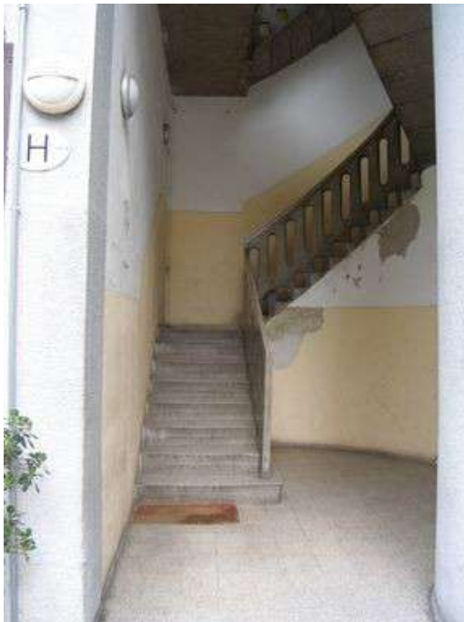
Vista vano scala A
